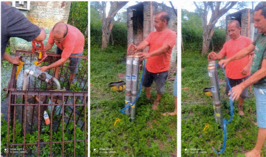
Imagem 06 – Desmontagem do equipamento submerso; conj. Moto-bomba submersa; montagem e instalação de conjunto moto-bomba submersível (eixo vertical) em poços tubulares; abraçadeira de nylon para amarração de cabos e teste de produção com bomba; distribuição de rede de água; instalação de reservatório.
