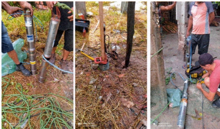
Imagem 07 – Desmontagem do equipamento submerso; conj. Moto-bomba submersa; montagem e instalação de conjunto moto-bomba submersível (eixo vertical) em poços tubulares; abraçadeira de nylon para amarração de cabos e teste de produção com bomba; distribuição de rede de água; instalação de reservatório.
