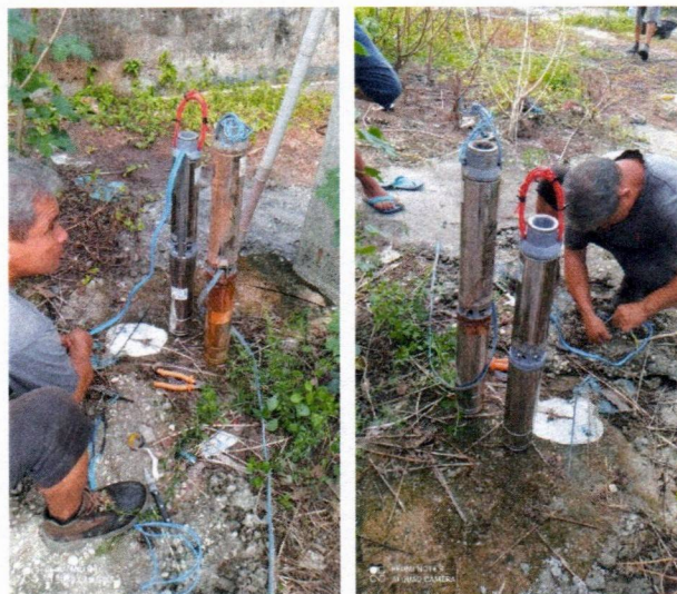
Imagem 08 – Desmontagem do equipamento submerso; conj. Moto-bomba submersa; montagem e instalação de conjunto moto-bomba submersível (eixo vertical) em poços tubulares; abraçadeira de nylon para amarração de cabos e teste de produção com bomba; distribuição de rede de água; instalação de reservatório.
