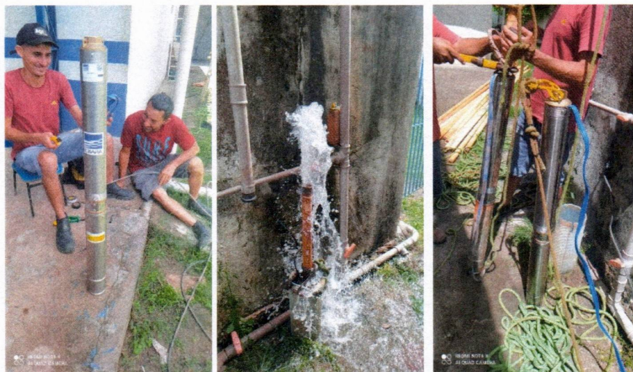
Imagem 04 – Desmontagem do equipamento submerso; conj. Moto-bomba submersa; montagem e instalação de conjunto moto-bomba submersível (eixo vertical) em poços tubulares; abraçadeira de nylon para amarração de cabos e teste de produção com bomba; distribuição de rede de água; instalação de reservatório.
