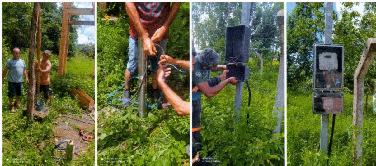
Imagem 07 – Desmontagem do equipamento submerso; conj. Moto-bomba submersa; montagem e instalação de conjunto moto-bomba submersível (eixo vertical) em poços tubulares; abraçadeira de nylon para amarração de cabos e teste de produção com bomba; distribuição de rede de água; instalação de reservatório.
