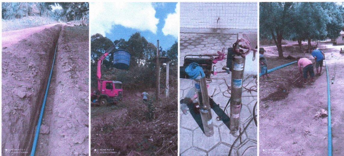
Imagem 04 – Desmontagem do equipamento submerso; conj. Moto-bomba submersa; montagem e instalação de conjunto moto-bomba submersível (eixo vertical) em poços tubulares; abraçadeira de nylon para amarração de cabos e teste de produção com bomba; distribuição de rede de água; instalação de reservatório.
