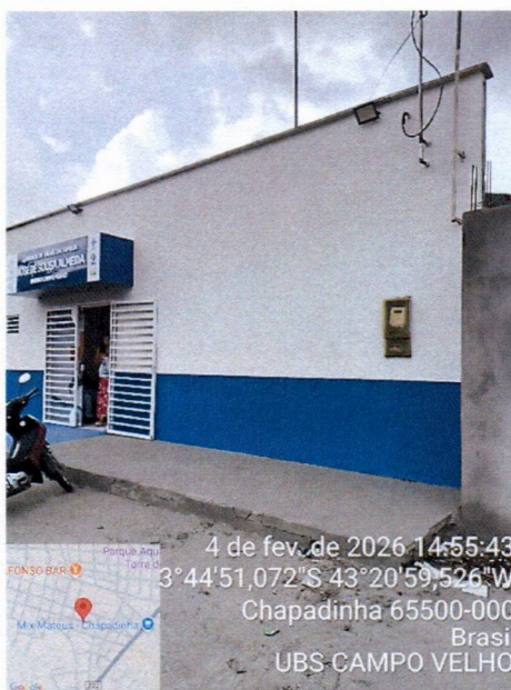
Imagem 2 – Pintura da fachada e instalação da placa em acm.
