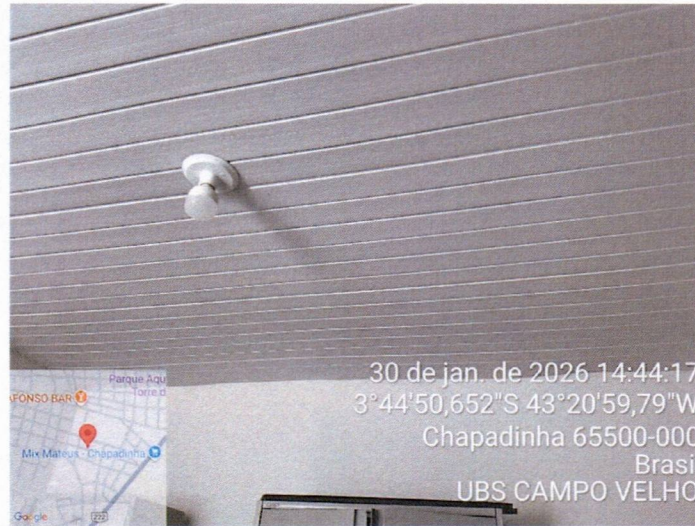
Imagem 13 – Substituição das lâmpadas queimadas e revisao do forro pvc.
