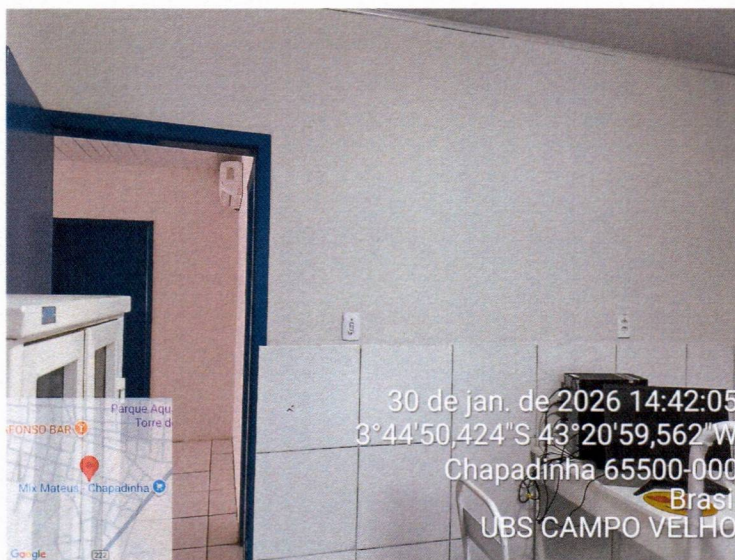
Imagem 12 – Pintura interna da ubs.
