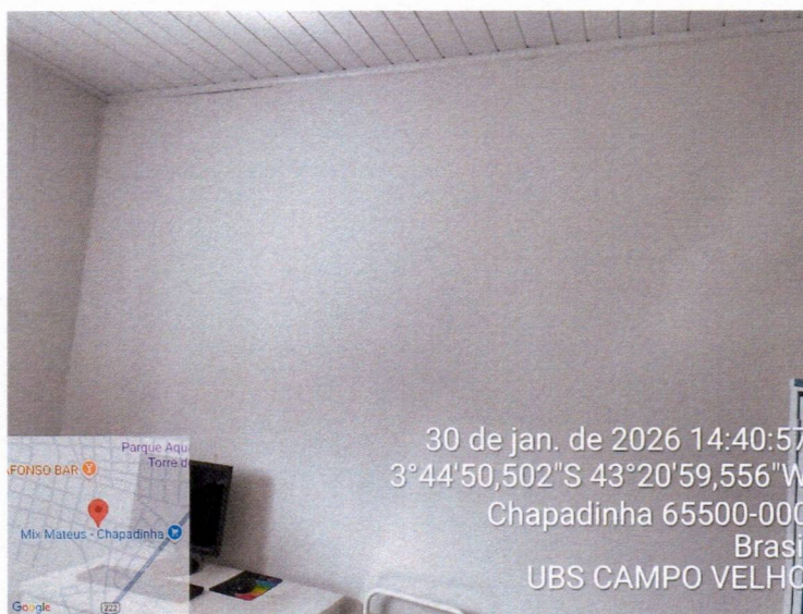
Imagem 10 – Pintura interna da ubs..
