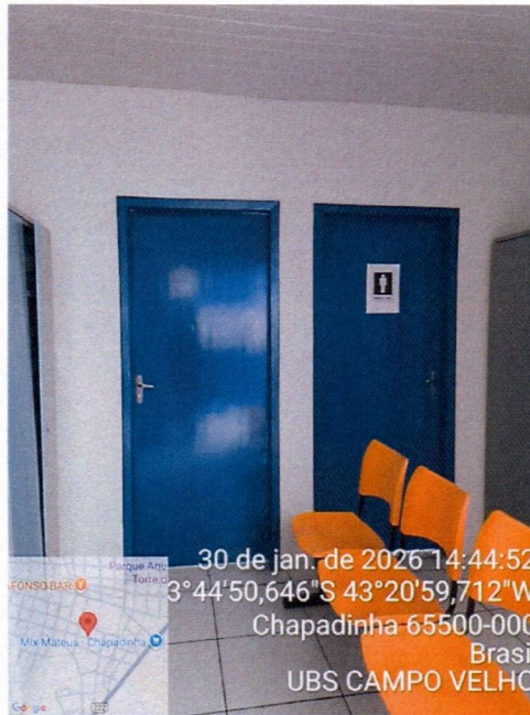
Imagem 7 – Pintura interna da ubs e pintura das esquadrias de madeira.
