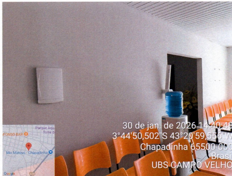
Imagem 8 – Pintura interna da ubs.
