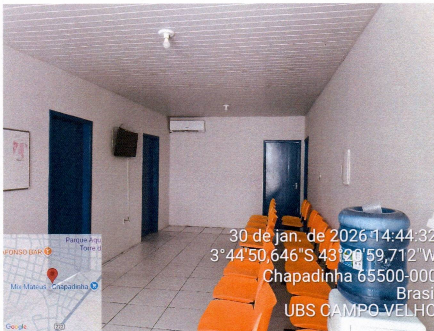
Imagem 6 – Pintura interna da ubs e pintura das esquadrias de madeira.
