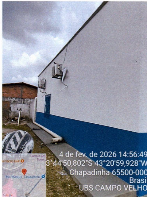
Imagem 3 – Pintura externa, pintura das grades e pintura da calçada.
