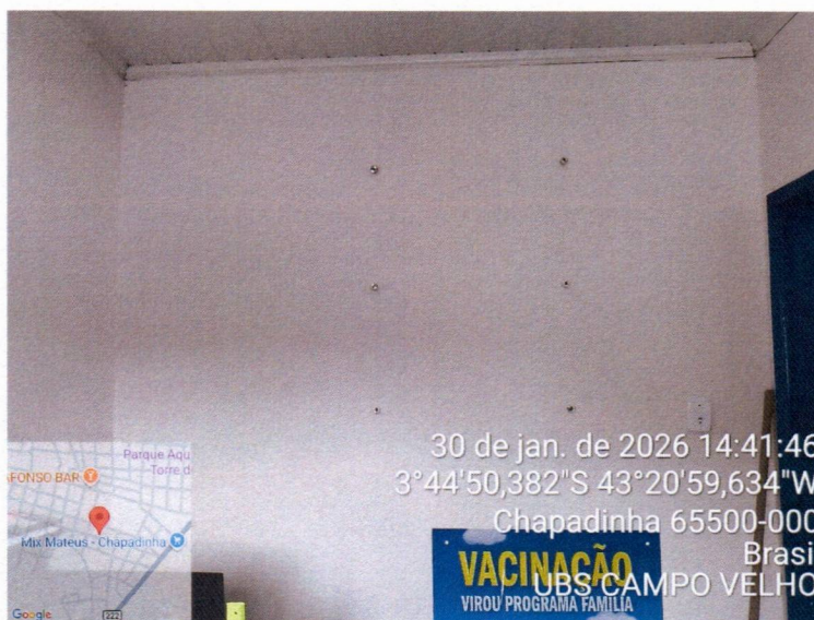
Imagem 9 – Pintura interna da ubs.
