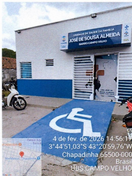
Imagem 1 – Pintura da fachada e instalação da placa em acm.
