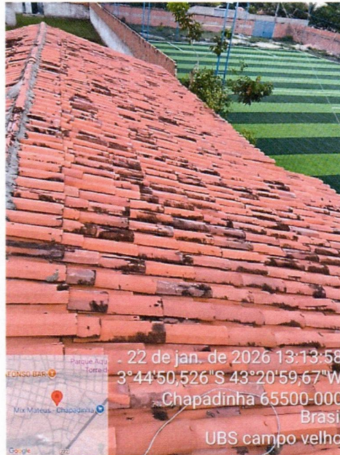
Imagem 5 – Retelhamento com telha cerâmica.
