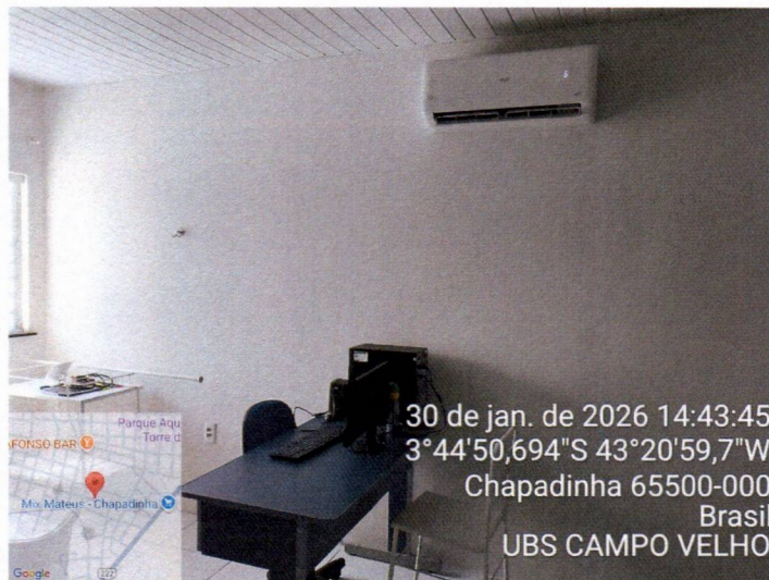
Imagem 11 – Pintura interna da ubs.
