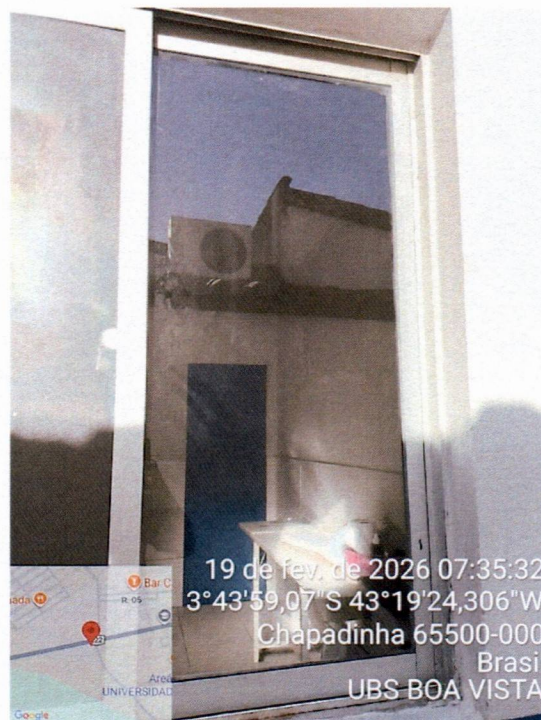
Imagem 16 – Substituição das esquadrias em vidro danificadas.
