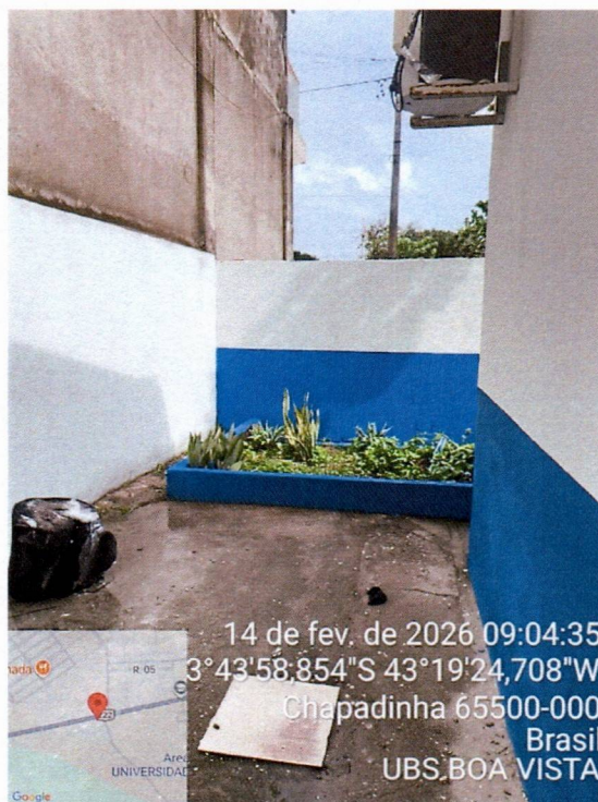
Imagem 6 – Pintura externa do prédio.
