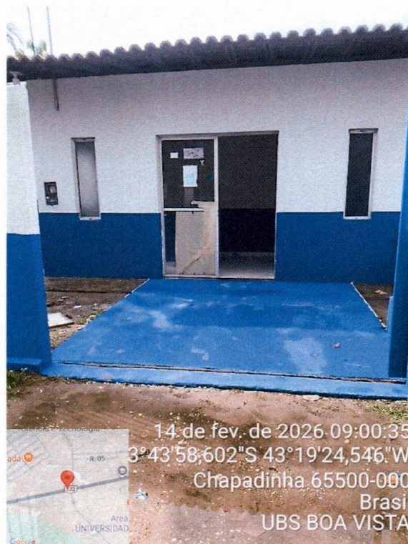
Imagem 2 – Pintura externa, pintura das grades e pintura da calçada.
