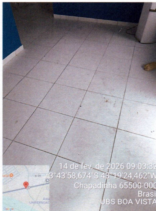
Imagem 12 – Substituição de revestimento cerâmico interno.
