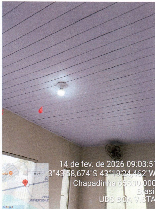
Imagem 15 – Revisão do forro em pvc e substituição das lampadas de led.
