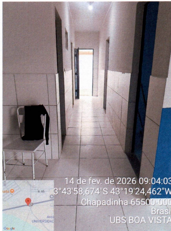
Imagem 13 – Pintura interna e substituição de lâmpadas em led.
