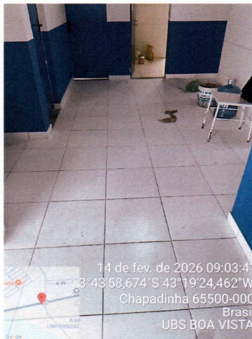
Imagem 10 – Substituição de revestimento cerâmico interno e pintura interna.
