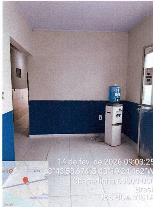
Imagem 9 – Substituição de revestimento cerâmico interno e pintura interna.
