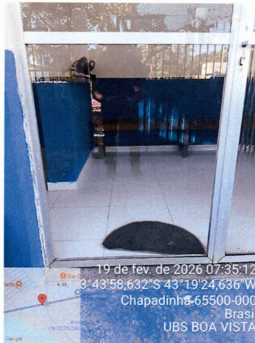
Imagem 17 – Substituição das esquadrias em vidro danificadas.
