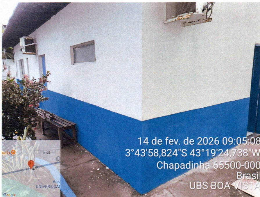
Imagem 5 – Pintura externa do prédio.
