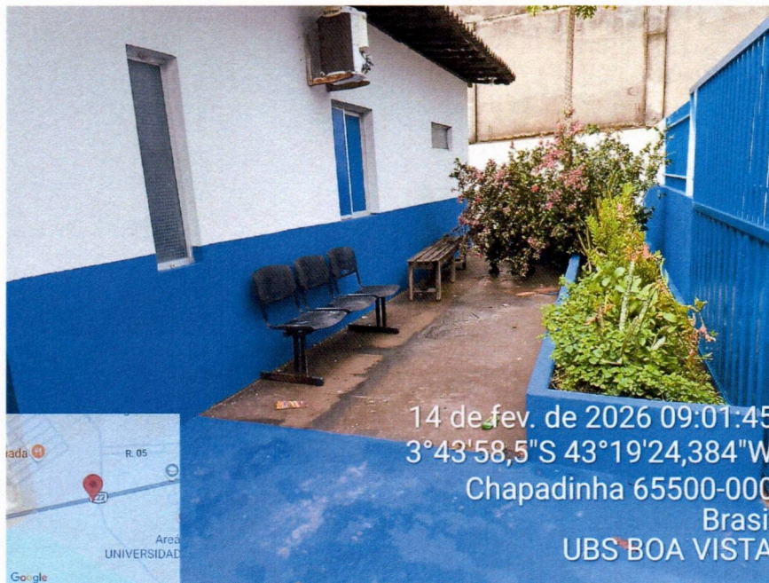
Imagem 4 – Pintura externa, pintura das grades e pintura da calçada.
