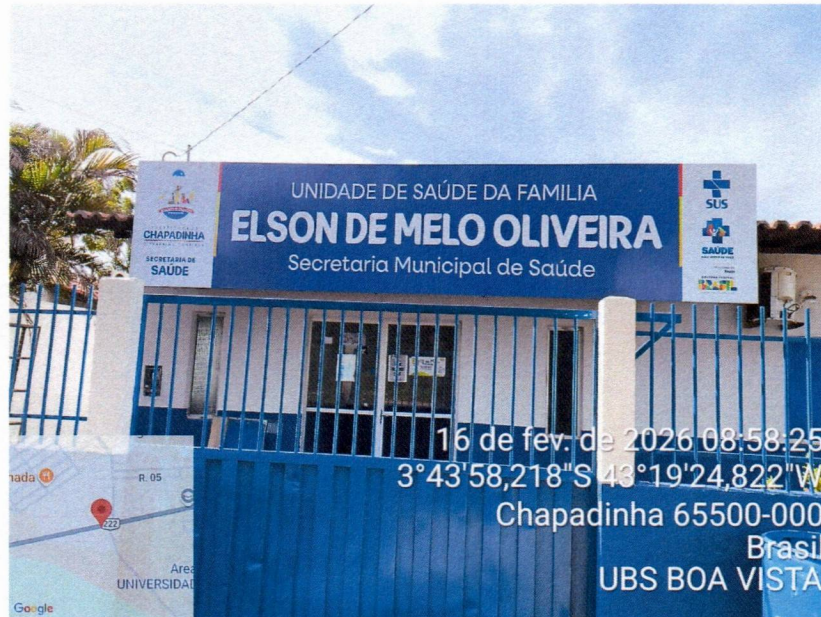
Imagem 1 – Pintura da fachada e instalação da placa em lona.
