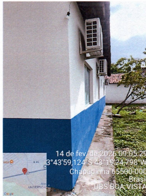
Imagem 7 – Pintura externa do prédio.
