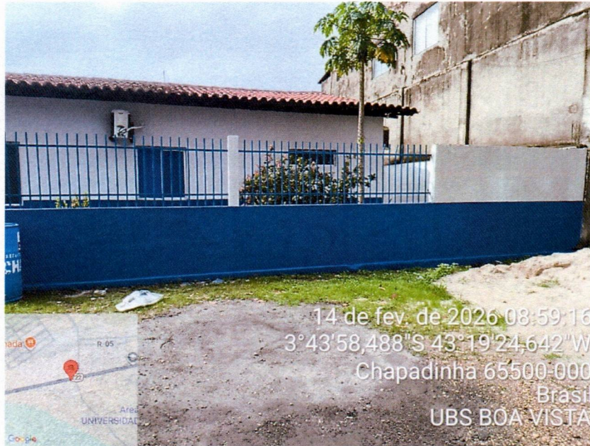
Imagem 3 – Pintura externa e pintura das grades.
