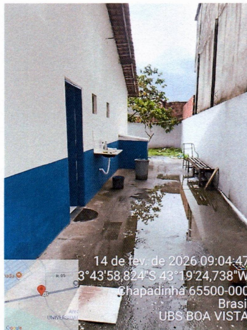
Imagem 8 – Pintura externa do prédio.
