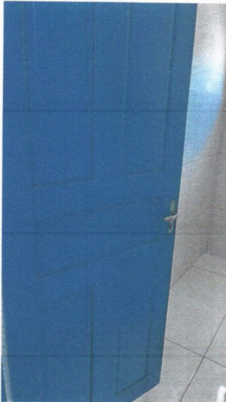
Imagem 9 – Pintura das esquadrias de madeira.
