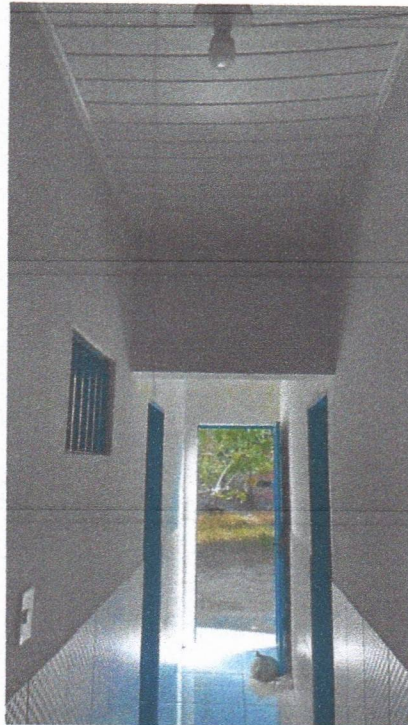
Imagem 5 – Pintura interna e substituição das lâmpadas queimadas.
