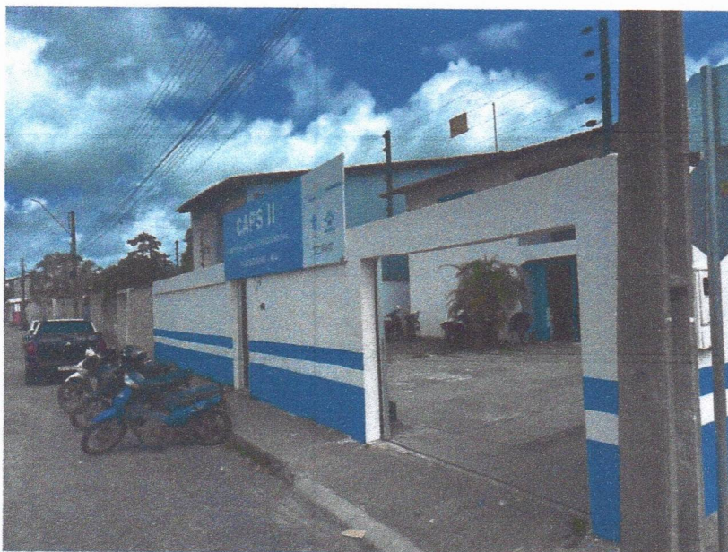
Imagem 1 – Pintura da fachada.
