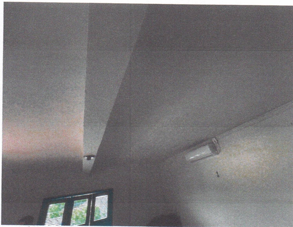
Imagem 5 – Pintura interna e instalação de pontos de tomadas nas salas.
