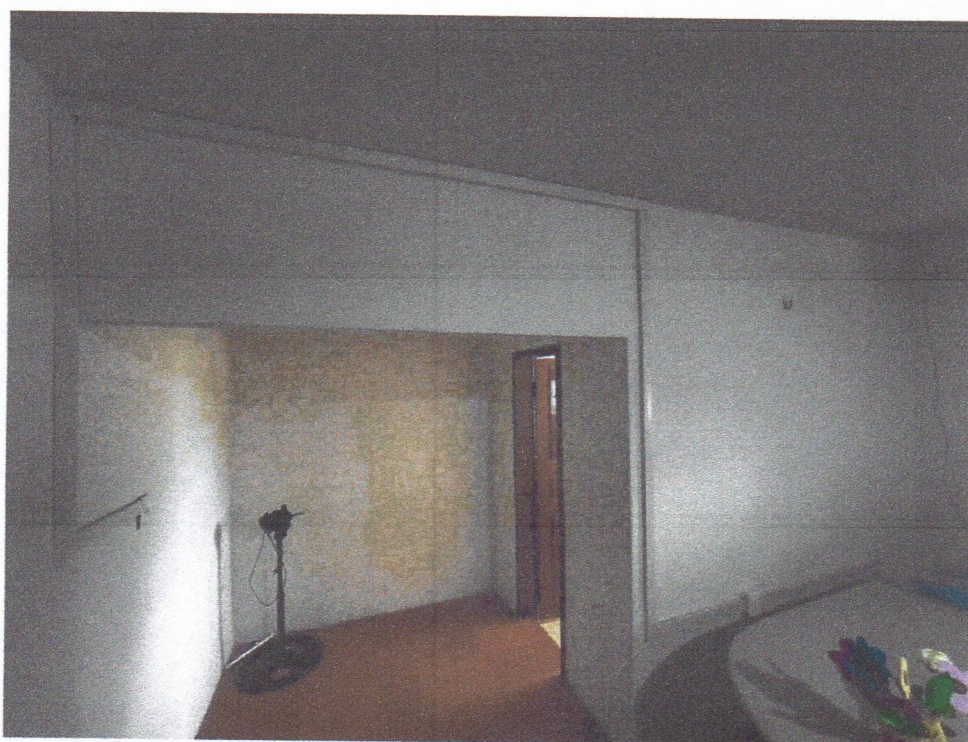
Imagem 6 – Pintura interna e instalação de pontos de tomadas nas salas.
