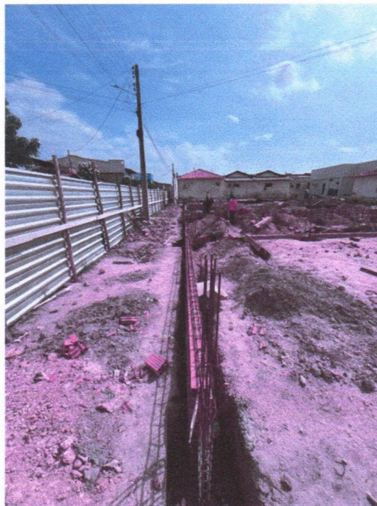
Imagem 4 – Execução do embasamento em alvenaria, sapatas e ferragens de vigas e pilares;
