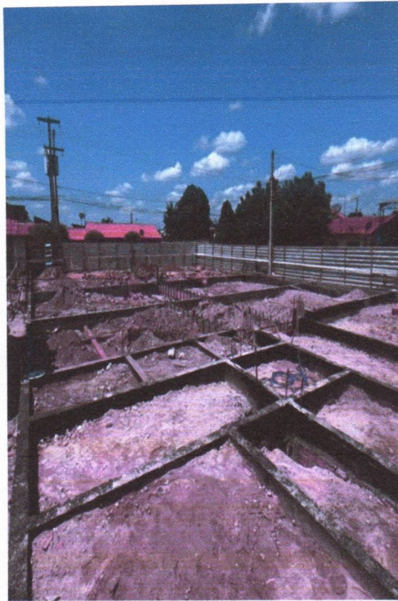
Imagem 9 – Execução das vigas baldramas e impermeabilizações;
