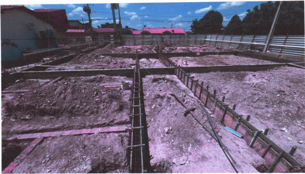
Imagem 3 – Instalação dos tapumes de fechamento;
