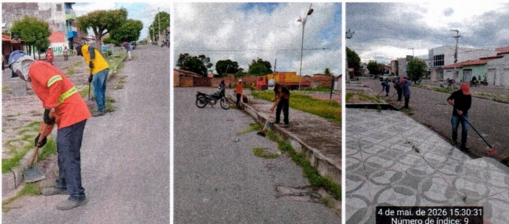
Imagem 02 – equipe realizando limpeza de ruas (varrição e remoção de entulhos), limpeza manual de vegetação com roçadeira em vias públicas e bota fora em caminhão basculante
