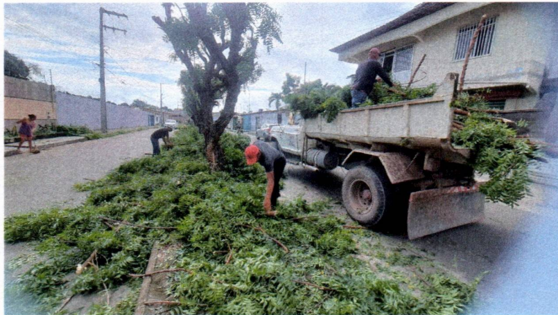
Imagem 01 – equipe realizando limpeza de ruas (varrição e remoção de entulhos), limpeza manual de vegetação com roçadeira em vias públicas e bota fora em caminhão basculante
