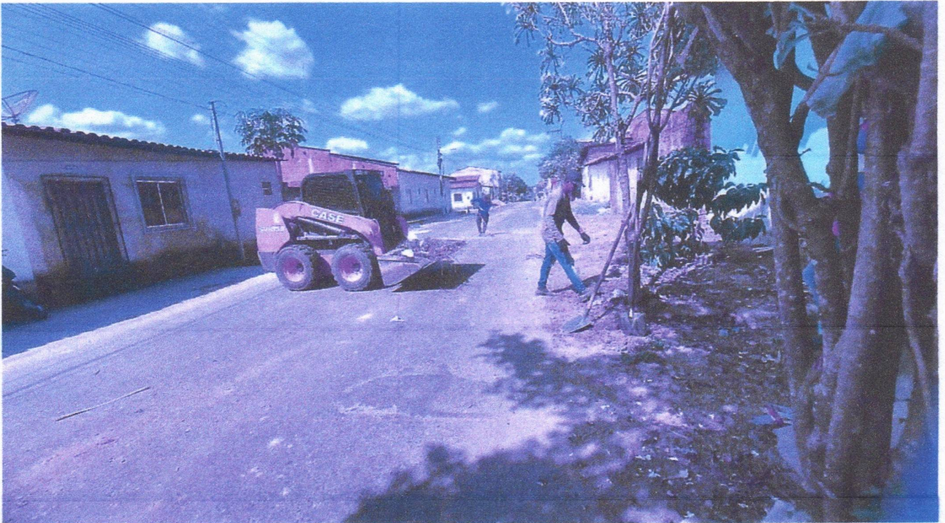
Imagem 06 – equipe realizando limpeza de ruas (varrição e remoção de entulhos), limpeza manual de vegetação em vias públicas e bota fora.
