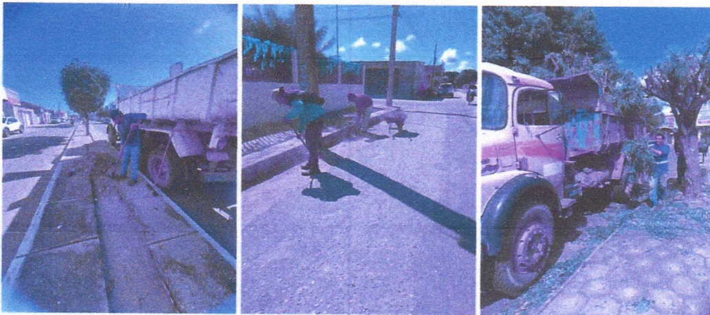
Imagem 02 – equipe realizando limpeza de ruas (varrição e remoção de entulhos), limpeza manual de vegetação com roçadeira em vias públicas e bota fora em caminhão basculante
