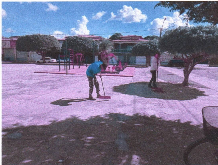
Imagem 06 – equipe realizando limpeza de ruas (varrição e remoção de entulhos), limpeza manual de vegetação em vias públicas e bota fora.
