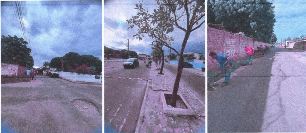
Imagem 05 – equipe realizando limpeza de ruas (varrição e remoção de entulhos), limpeza manual de vegetação em vias públicas e bota fora.
