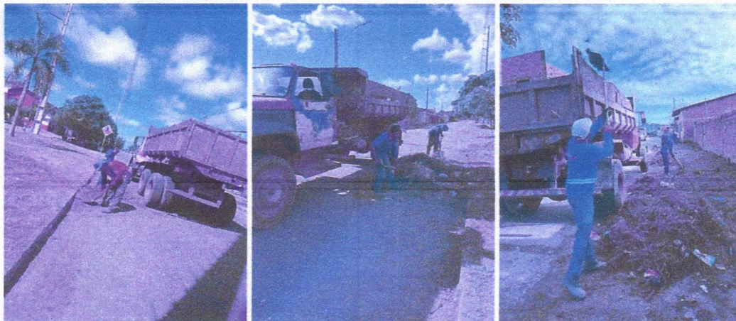
Imagem 03 – equipe realizando limpeza de ruas (varrição e remoção de entulhos), limpeza mecânica com roçadeira em vegetação em vias públicas.
