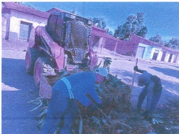
Imagem 01 – equipe realizando limpeza de ruas (varrição e remoção de entulhos), limpeza manual de vegetação com roçadeira em vias públicas e bota fora em caminhão basculante
