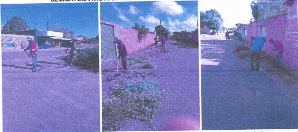
Imagem 05 – equipe realizando limpeza de ruas (varrição e remoção de entulhos), limpeza manual de vegetação em vias públicas e bota fora.
