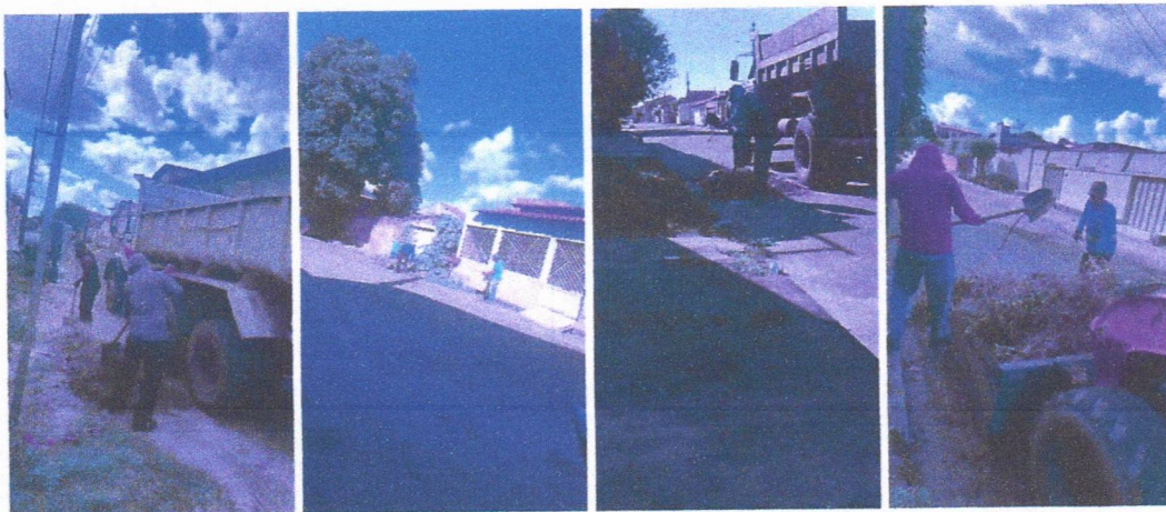
Imagem 06 – equipe realizando limpeza de ruas (varrição e remoção de entulhos), limpeza manual de vegetação em vias públicas e bota fora.
