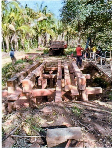
Foto: execução de superestrutura (tabuleiro de madeira, passa rodas, guias)
