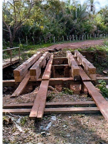
Foto: execução de superestrutura (tabuleiro de madeira, passa rodas, guias)
