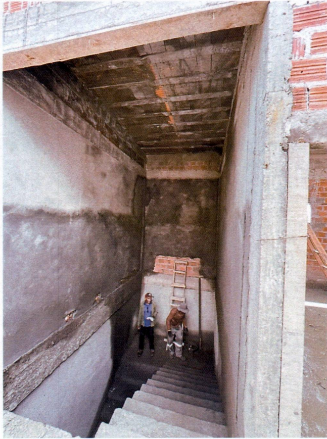
Imagem 9 – Execução parcial de reboco e laje da caixa d'água;
