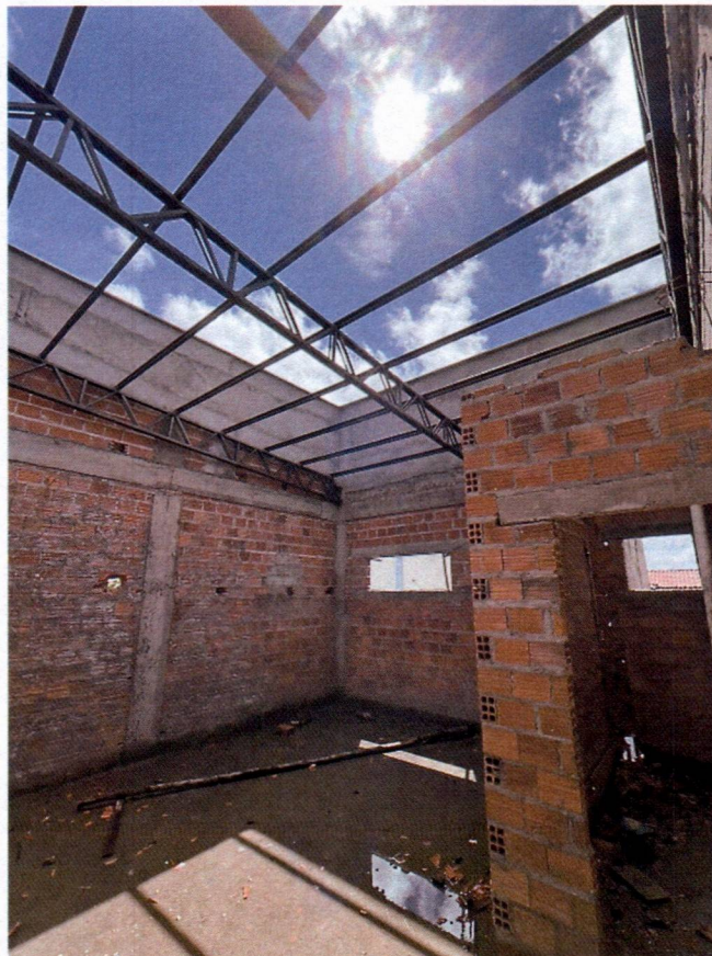
Imagem 10 – Execução da cobertura metálica;
