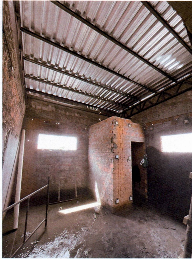
Imagem 13 – Execução da cobertura metálica;
