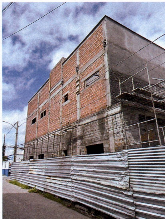
Imagem 1 – Finalização de alvenarias da platibanda, rebocos, cintas e pingadeiras;
