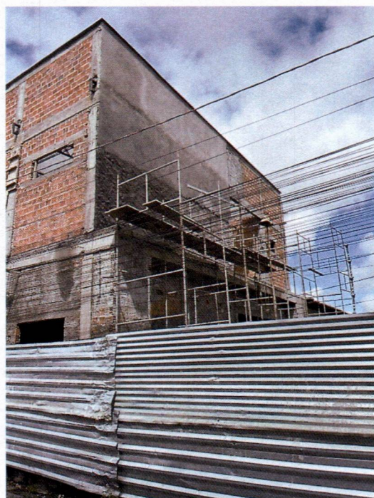
Imagem 2 – Finalização de alvenarias da platibanda, rebocos, cintas e pingadeiras;
