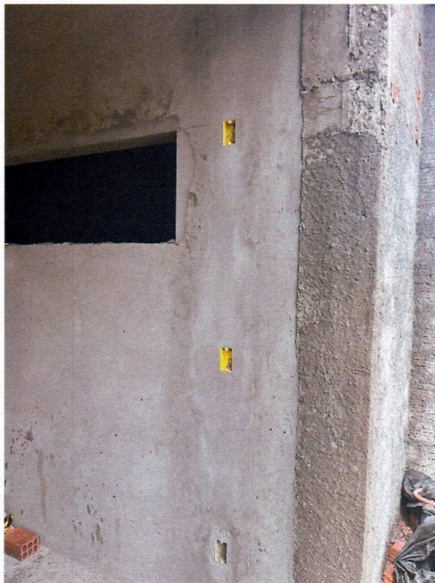
Imagem 6 – Execução de caixas elétricas;
