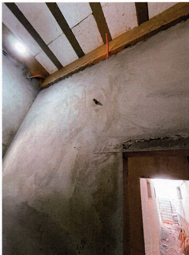
Imagem 10 – Instalação de drenos;
