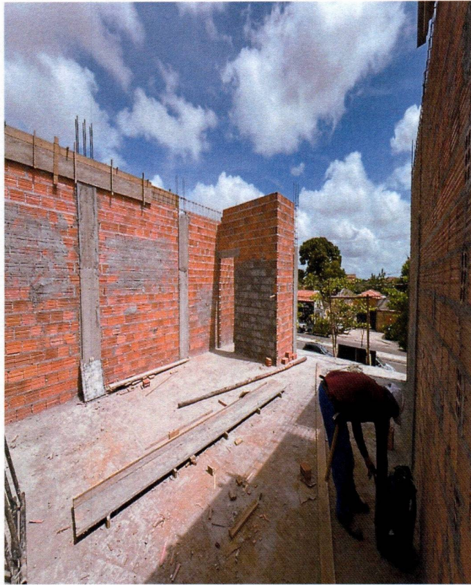
Imagem 17 – Execução da alvenaria superior, vigas e vergas;
