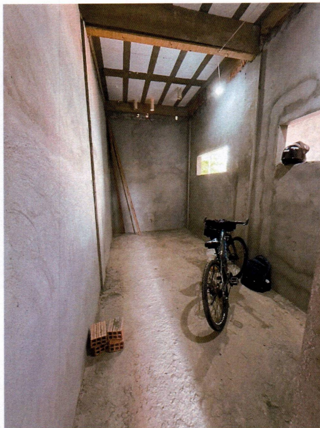
Imagem 9 – Execução de reboco e caixas elétricas;
