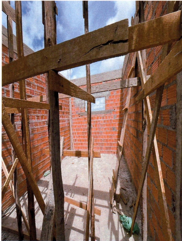
Imagem 18 – Execução da alvenaria superior, vigas e vergas;
