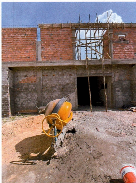
Imagem 1 – Execução de alvenaria, vigas/pilares e chapisco;
