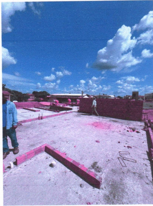
Imagem 3 – Finalização da laje;
