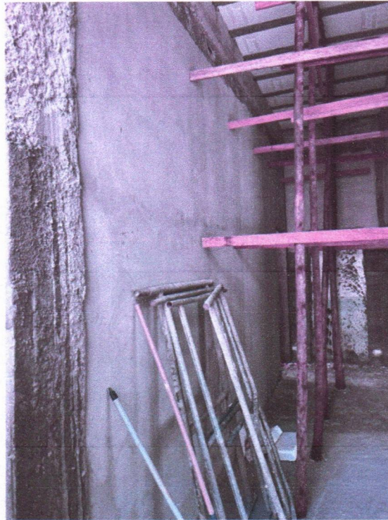
Imagem 11 – Reboco em execução.
