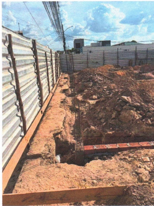
Imagem 6 – Execução dos embasamentos e sapatas;
