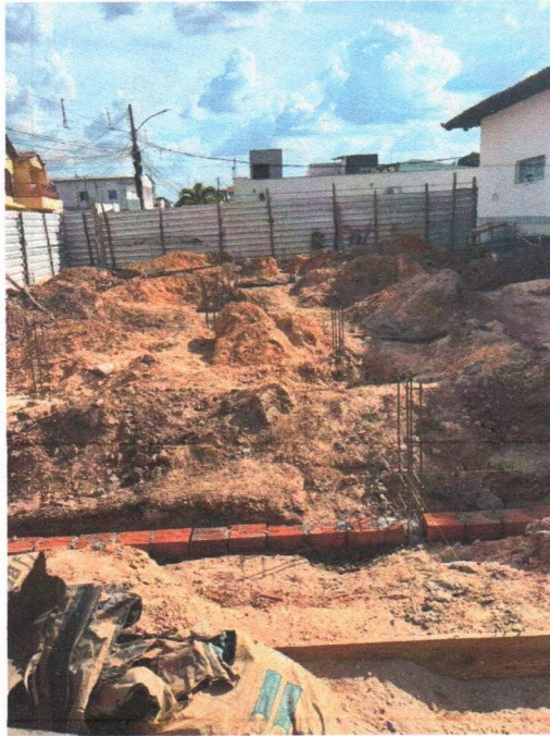
Imagem 5 – Execução das escavações;
