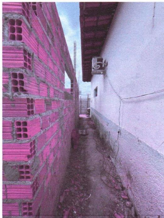
Imagem 2 – Execução de alvenaria e estruturas;
