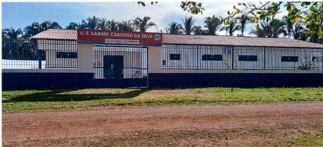
Imagem 1 – Pintura externa da escola e pintura das grades da fachada.
