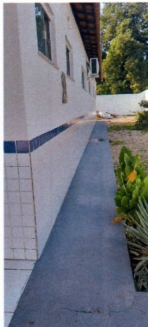
Imagem 3 – Pintura externa da escola e pintura das calçadas.
