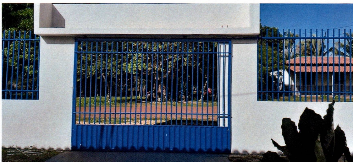
Imagem 2 – Pintura externa da escola e pintura das grades da fachada.
