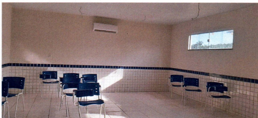
Imagem 8 – Execução da pintura interna das salas e substituição das luminárias.
