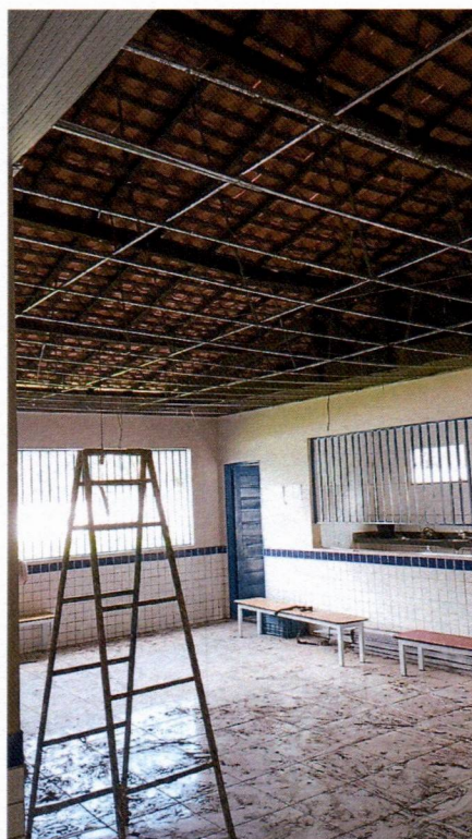
Imagem 4 – Remoção do forro pvc, para instalação de novas placas.
