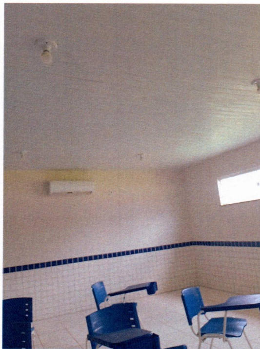
Imagem 6 – Execução da pintura interna das salas e substituição das luminárias.
