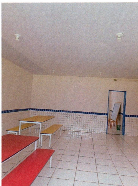
Imagem 9 – Execução da pintura interna e substituição das luminárias.
