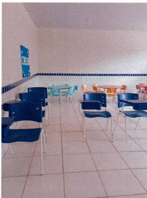
Imagem 8 – Execução da pintura interna das salas e substituição das luminárias.
