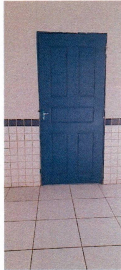
Imagem 9 – Pintura das esquadrias de madeira.
