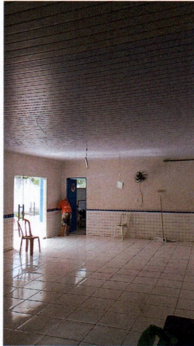
Imagem 5 – Instalação de novas placas de forro pvc e pintura interna da escola.
