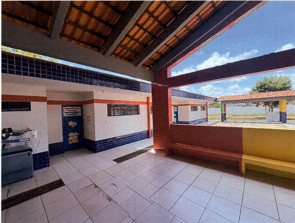
Imagem 11 – Pintura externa da creche e substituição de revestimento cerâmico 45x45 cm.
