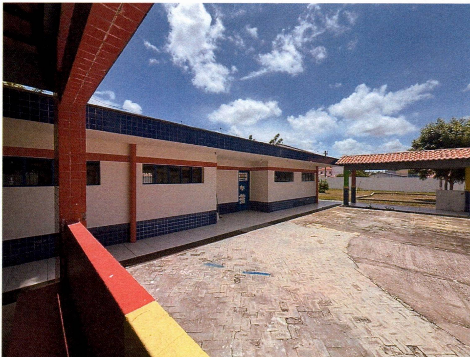
Imagem 12 – Pintura externa e retelamento da cobertura.
