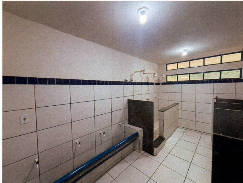
Imagem 22 – Execução de revisão hidráulica e sanitária dos banheiros.
