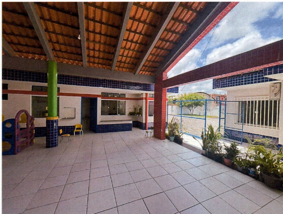
Imagem 8 – Pintura externa da creche e substituição de revestimento cerâmico 45x45 cm.
