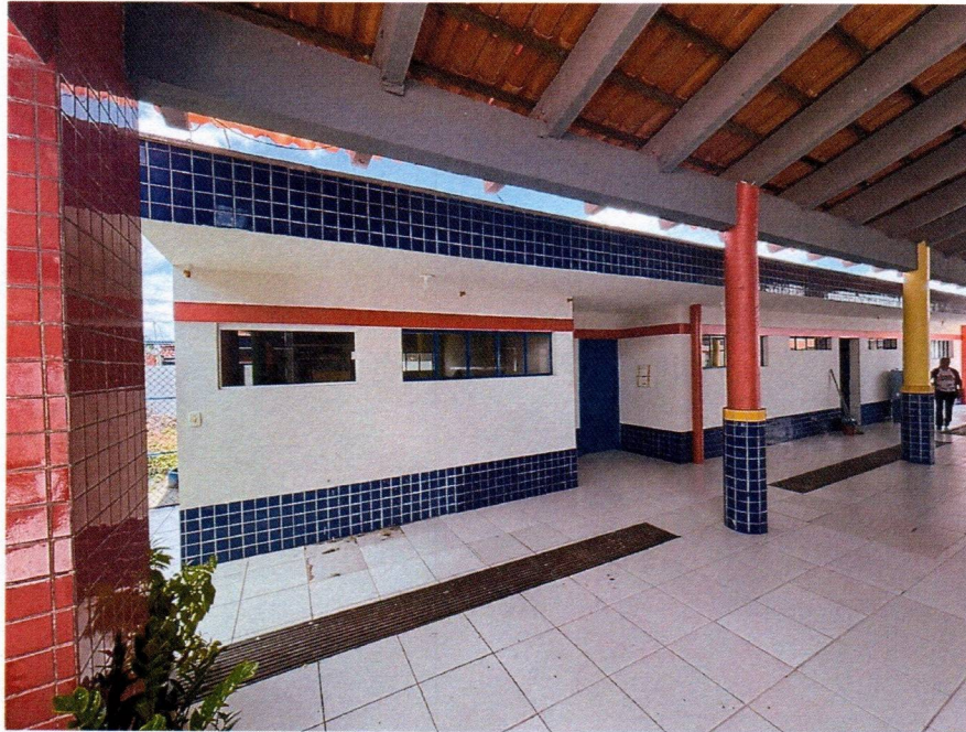
Imagem 9 – Pintura externa da creche e substituição de revestimento cerâmico 45x45 cm.
