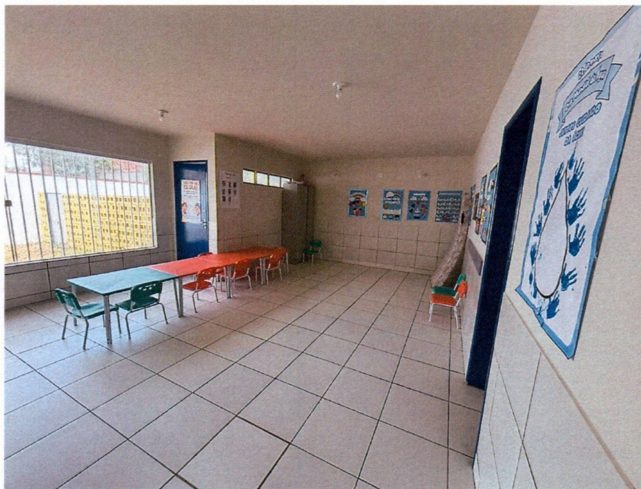
Imagem 16 – Pintura interna das salas, pintura do teto e pintura das esquadrias de madeira.
