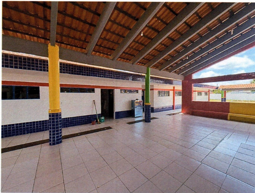
Imagem 10– Pintura externa da creche e substituição de revestimento cerâmico 45x45 cm.
