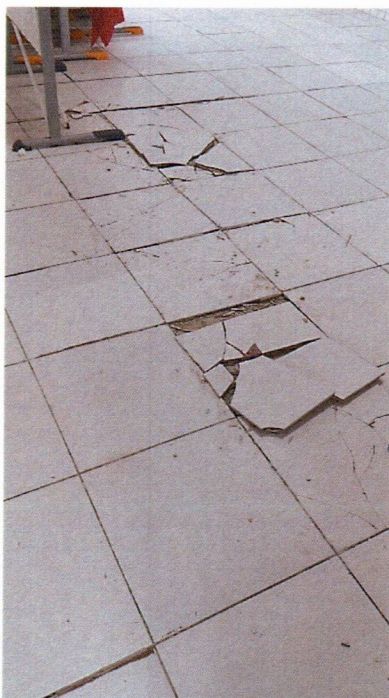
Imagem 6 – Demolição do piso cerâmico 45x45 cm danificado do patio.
