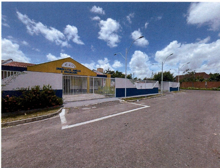
Imagem 1 – Pintura externa da fachada e pintura das esquadrias mélicas.
