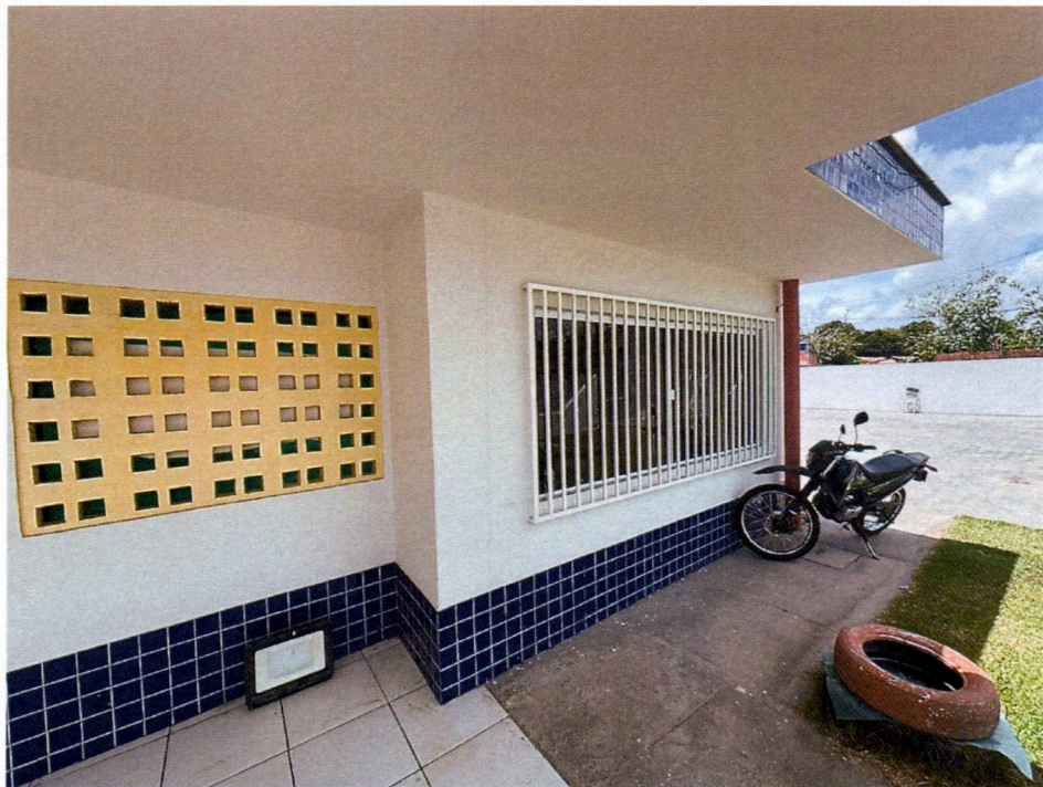
Imagem 4 – Pintura externa da creche e pintura das grades.
