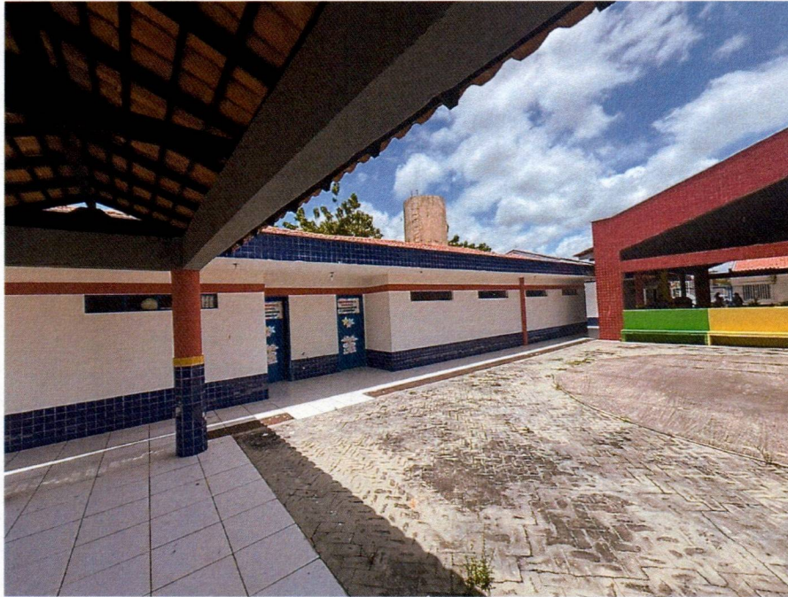
Imagem 13 – Pintura externa e pintura das esquadrias de madeira.
