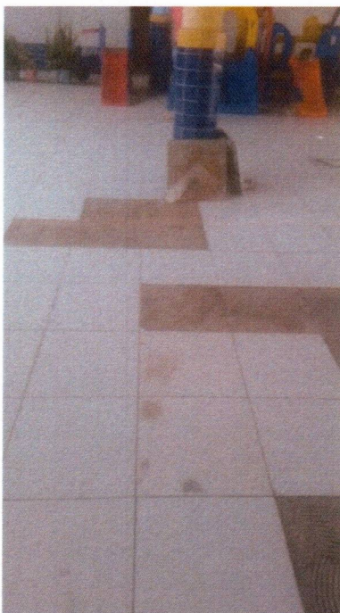
Imagem 5 – Demolição do piso cerâmico 45x45 cm danificado do patio.
