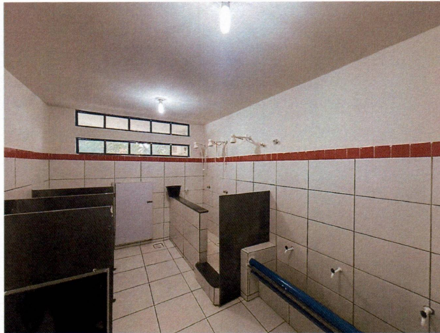
Imagem 21 – Execução de revisão hidráulica e sanitária dos banheiros.
