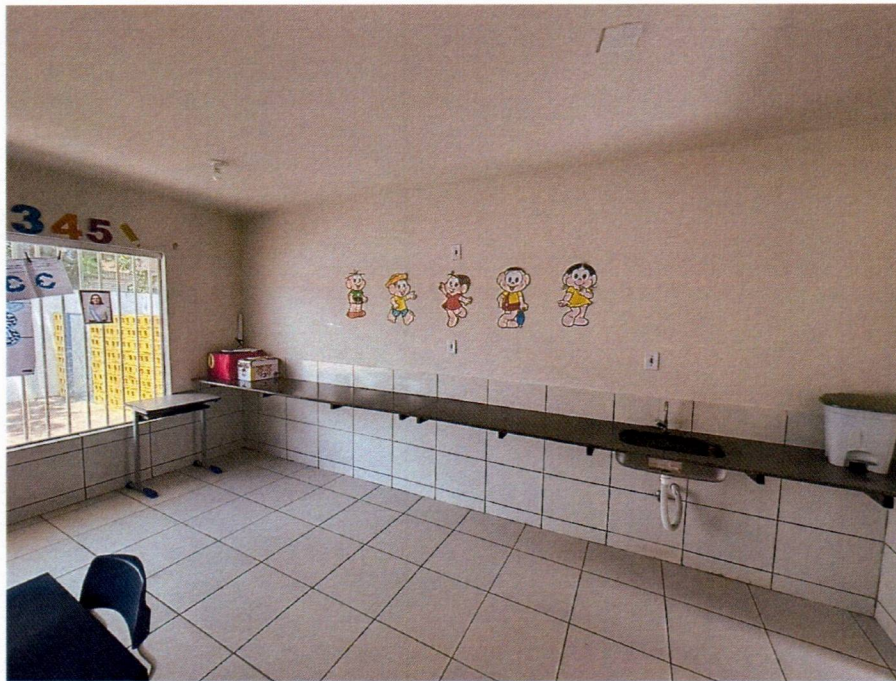
Imagem 17 – Pintura interna das salas e pintura do teto.
