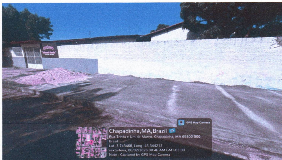
Imagem 9 – Execução da calçada externa.
