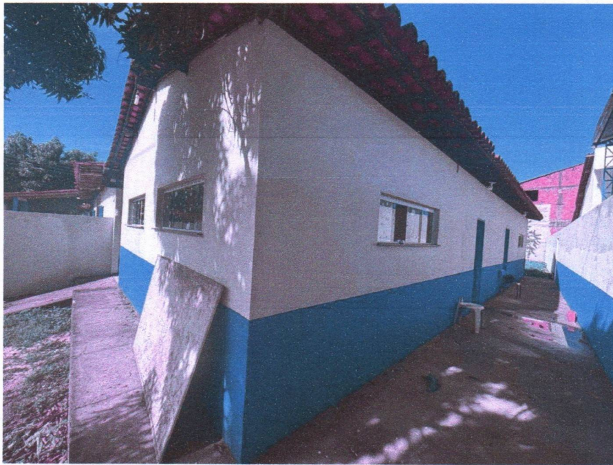
Imagem 1 – Pintura externa das salas e instalação de janelas de vidro.
