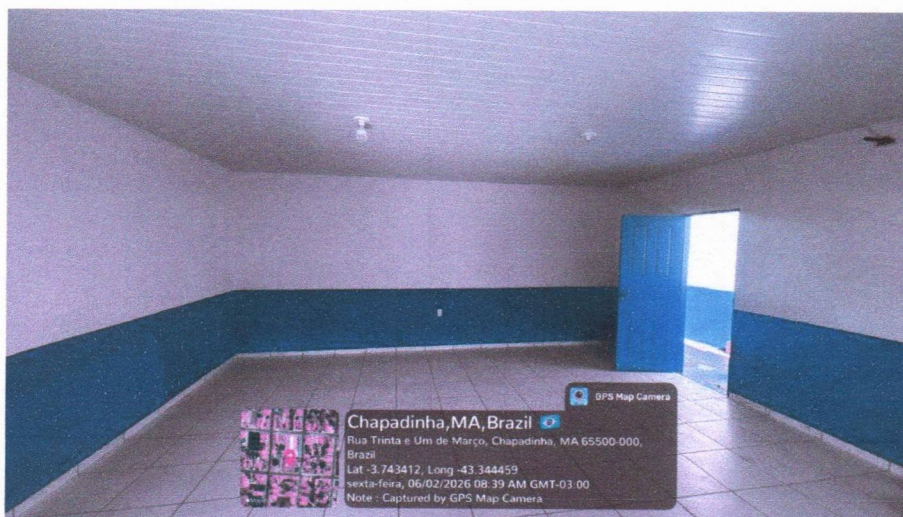
Imagem 2 – Pintura interna das salas, instalação do forro de pvc e instalação da esquadrias de madeira.
