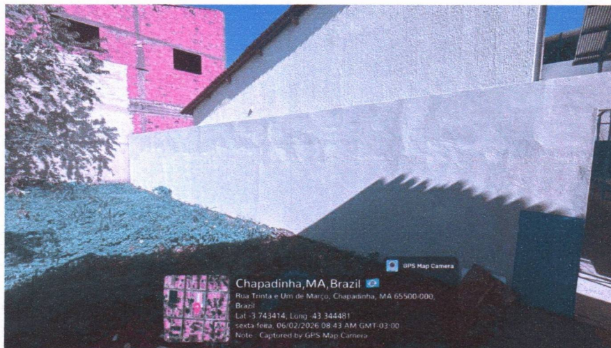
Imagem 8 – Pintura externa das salas.
