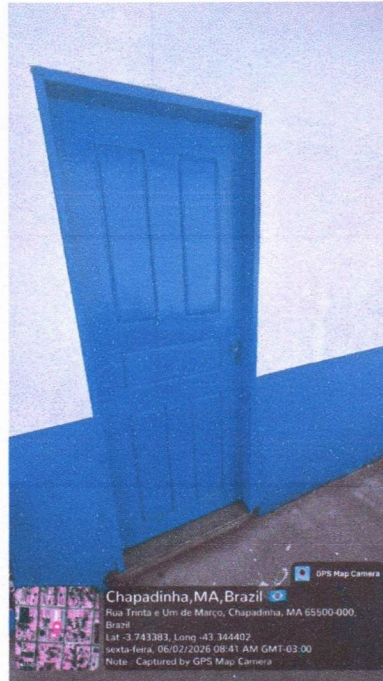
Imagem 5 – Instalação e pintura das esquadrias de madeira.
