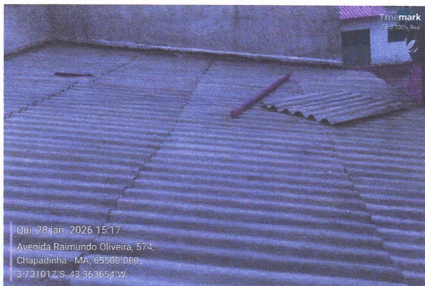
Imagem 5 – Execução do telhado de fibrocimento.
