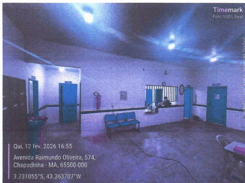
Imagem 9 – Pintura interna da escola, substituição do forro em pvc e instalação de luminarias.
