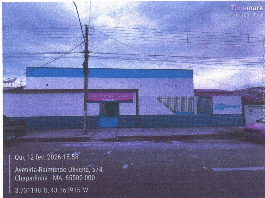
Imagem 1 – Pintura da fachada da escola.
