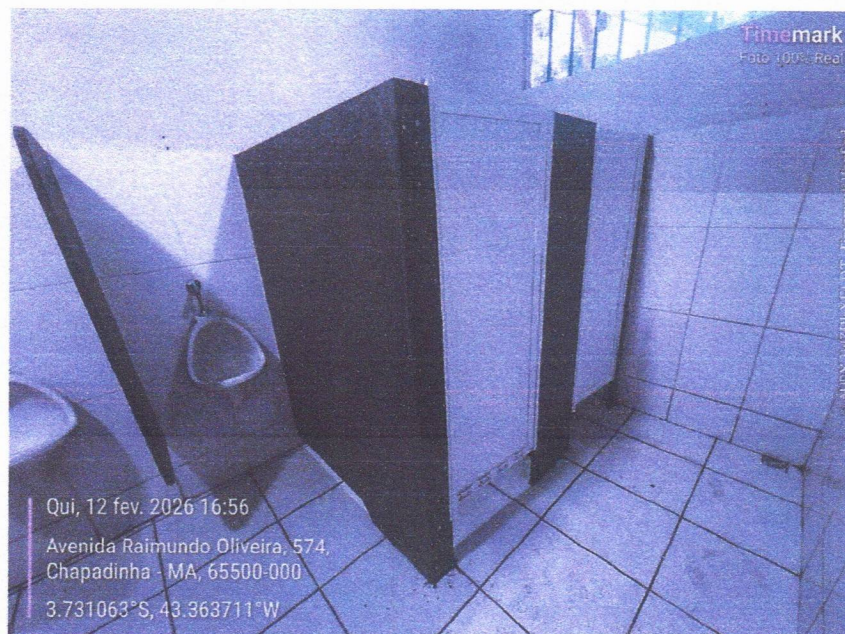
Imagem 16 – Pintura interna dos banheiros e substituição das portas em aluminio.
