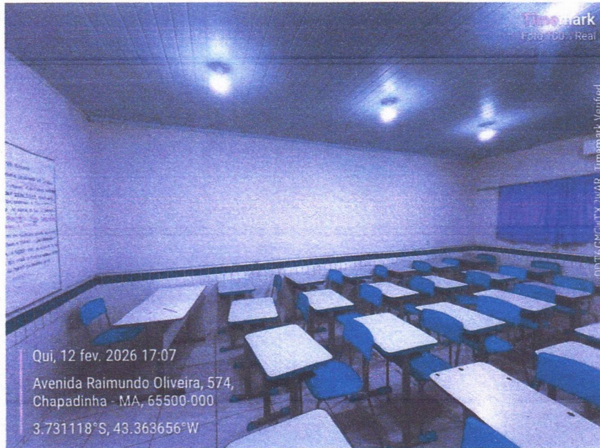
Imagem 21 – Pintura interna das salas e substituição de luminárias.
