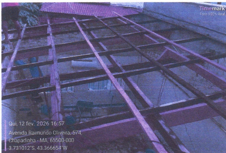
Imagem 4 – Remoção do telhado de fibrocimento e substituição da trama de madeira dessa área.
