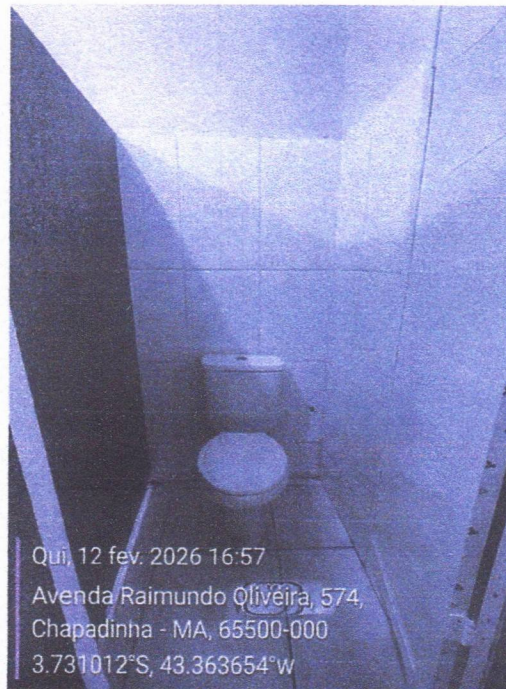
Imagem 18 – Substituição do vaso sanitário do banheiro.
