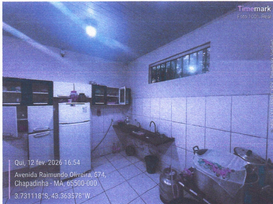
Imagem 14 – Pintura interna e substituição do forro de pvc.
