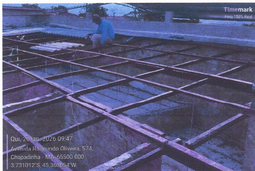
Imagem 2 – Remoção do telhado de fibrocimento.
