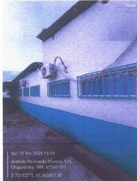
Imagem 13 – Pintura externa da escola e substituição do telhado de fibrocimento.
