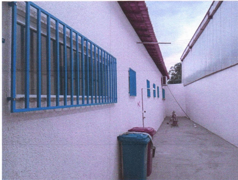
Imagem 9 – Pintura externa e pintura das esquadrias metálicas.
