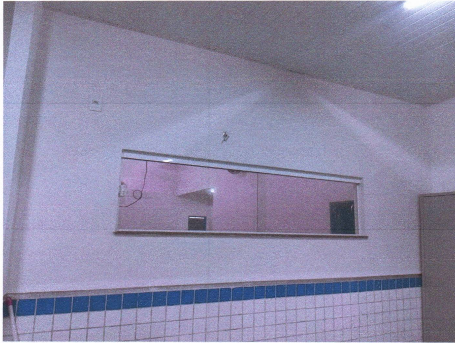
Imagem 7 – Pintura interna da escola e pintura das esquadrias de madeira.
