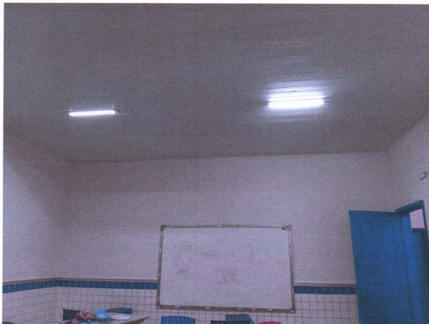
Imagem 4 – Pintura interna da escola e pintura das esquadrias de madeira.
