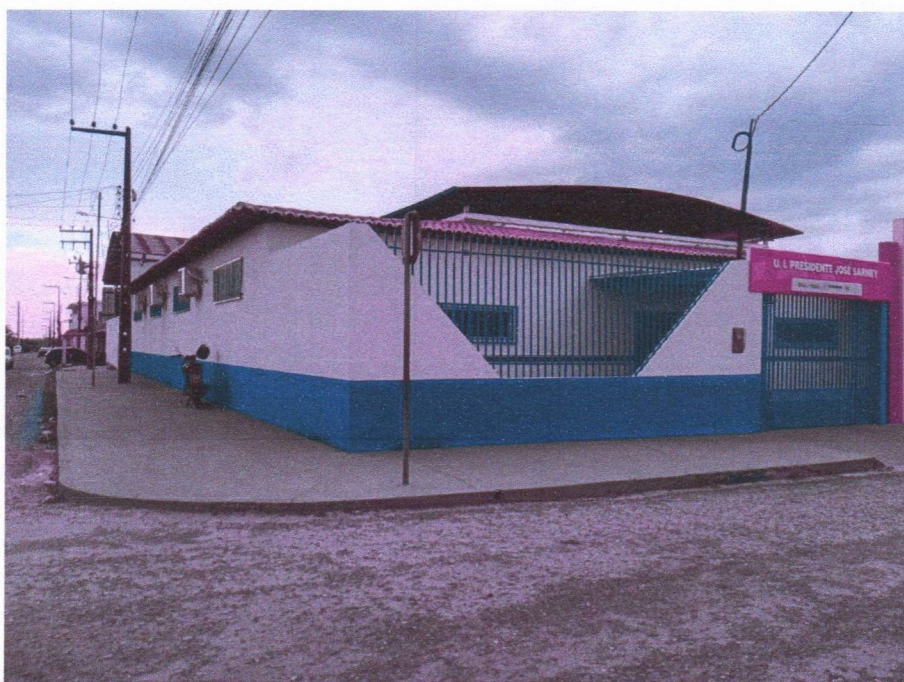
Imagem 2 – Pintura da fachada da escola e pintura do piso da calçada.
