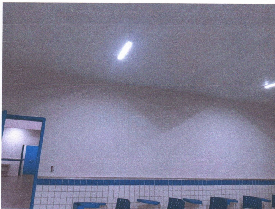
Imagem 6 – Pintura interna da escola e pintura das esquadrias de madeira.
