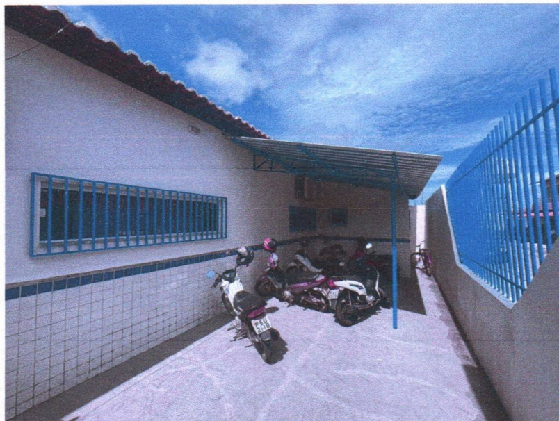
Imagem 11 – Execução da estrutura e cobertura metálica do estacionamento externo.
