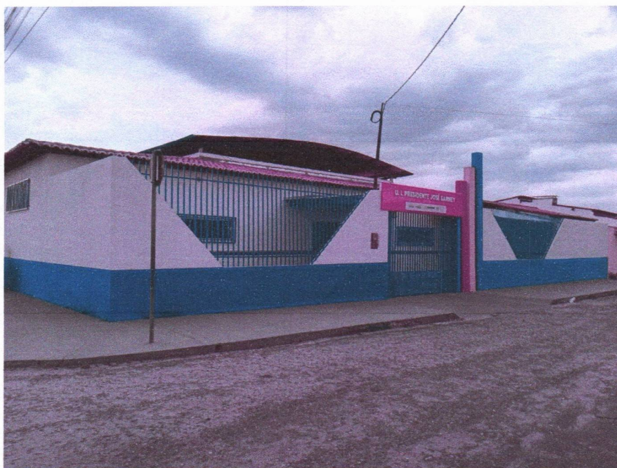
Imagem 1 – Pintura da fachada da escola.
