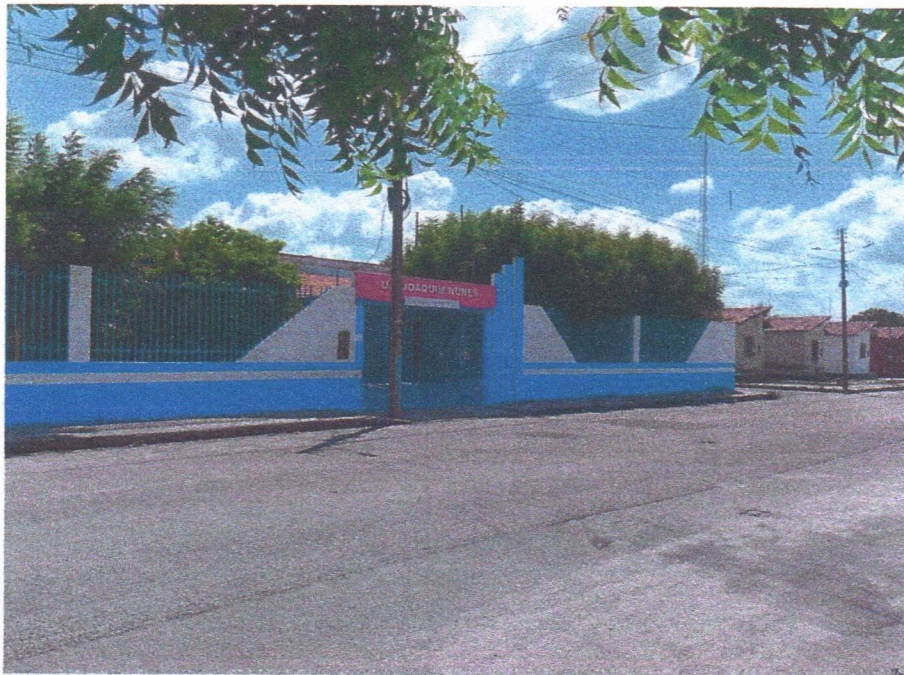
Imagem 2 – Pintura da fachada da escola.
