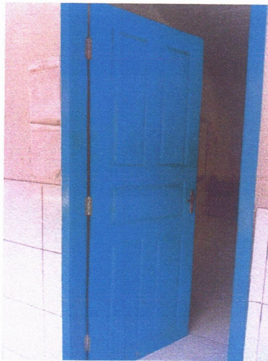
Imagem 8 – Pintura das esquadrias de madeira.
