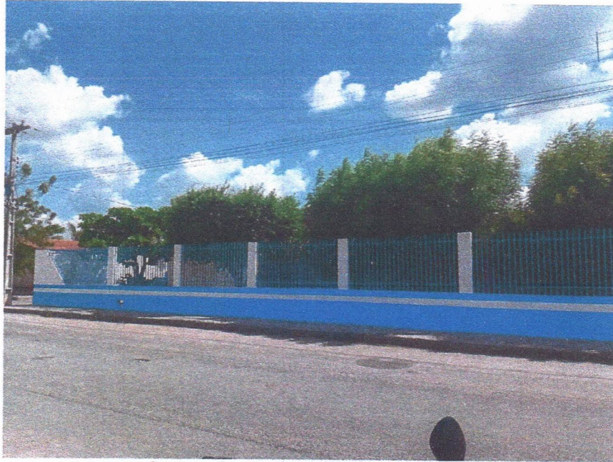
Imagem 3 – Pintura da fachada da escola.
