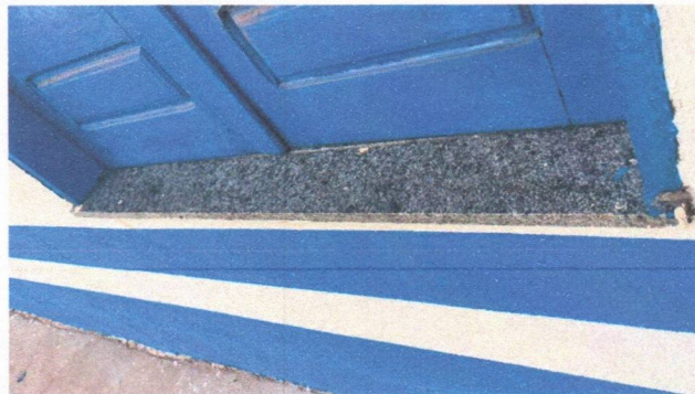
Imagem 7 – Instalação das soleiras em granito nas janelas.
