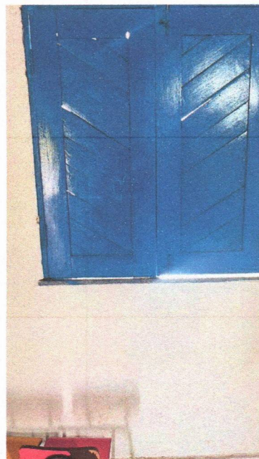
Imagem 6 – Pintura das esquadrias de madeira.
