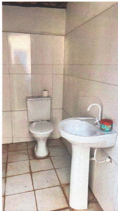
Imagem 8 – Substituição do vaso sanitário e da pia de louça com colunas nos banheiros da escola.
