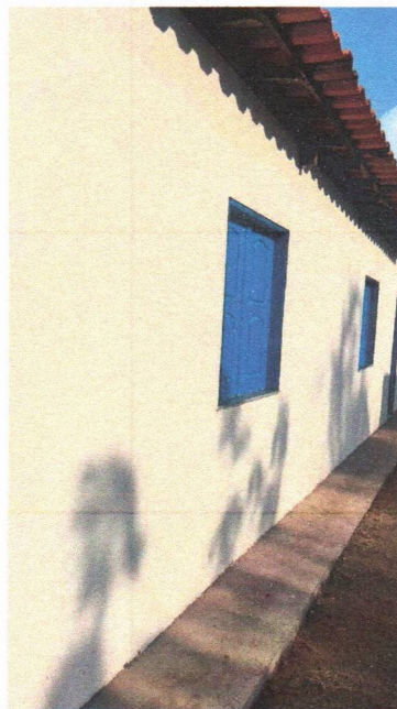
Imagem 2 – Pintura externa e pintura das esquadrias de madeira.
