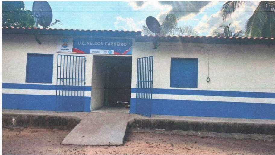
Imagem 1 – Pintura externa e pintura das esquadrias de madeira e metálica.
