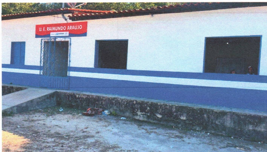
Imagem 1 – Pintura externa e execução da rampa de acesso a escola.
