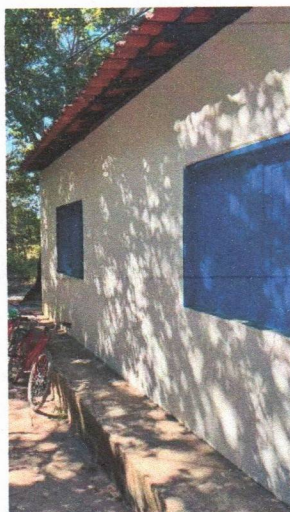
Imagem 3 – Pintura externa e pintura das esquadrias de madeira.
