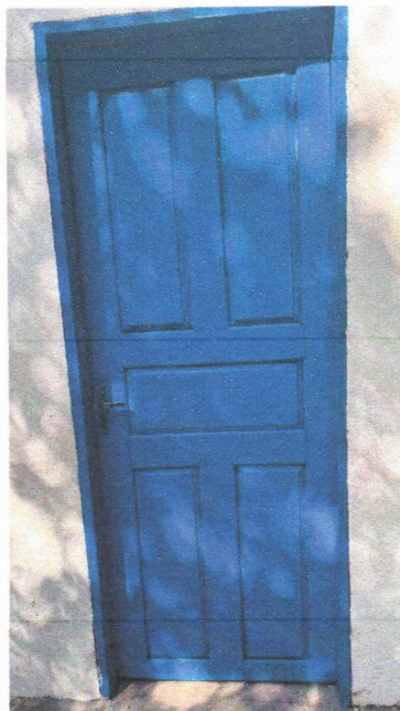
Imagem 5 – Pintura das esquadrias de madeira.
