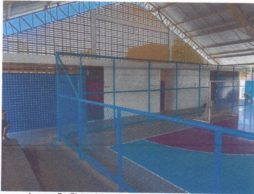
Imagem 7 – Pintura interna e pintura do alambrado metálico.
