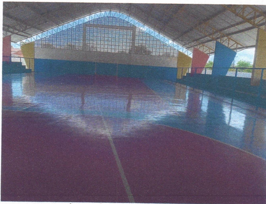
Imagem 8 – Pintura do piso da quadra.
