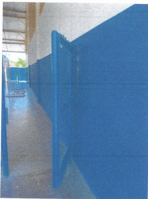
Imagem 10 – Pintura interna e pintura do alambrado metálico.
