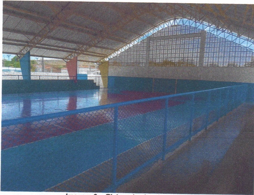
Imagem 9 – Pintura do piso da quadra.
