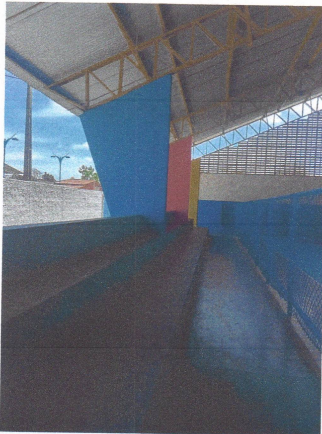
Imagem 6 – Pintura interna e pintura do alambrado metálico.
