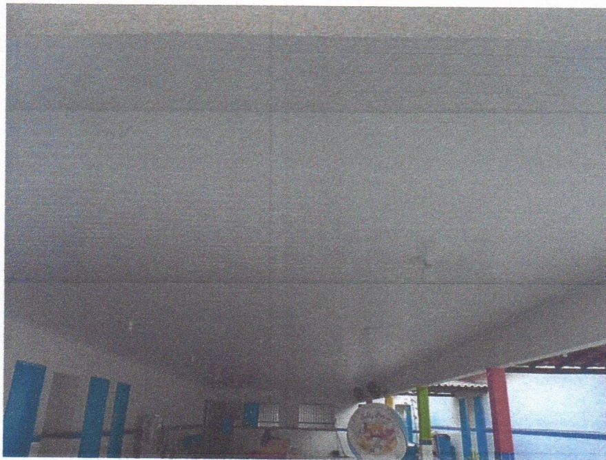
Imagem 12 – Instalação de Forro de PVC.
