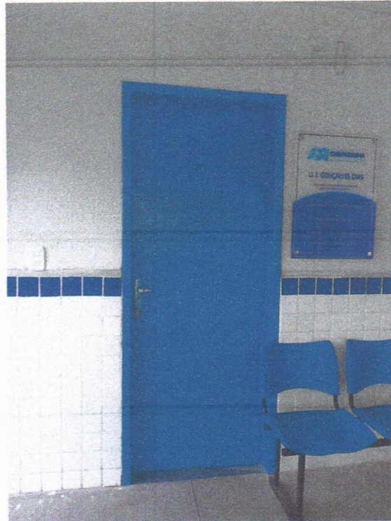
Imagem 13 – Pintura interna e pintura das esquadrias de madeira.
