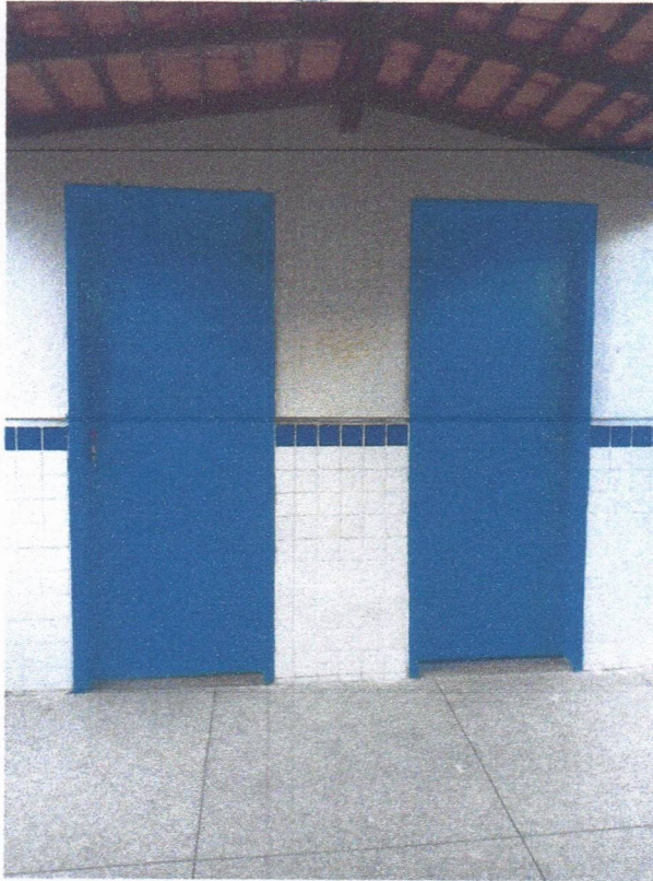
Imagem 15 – Pintura interna e pintura das esquadrias de madeira.
