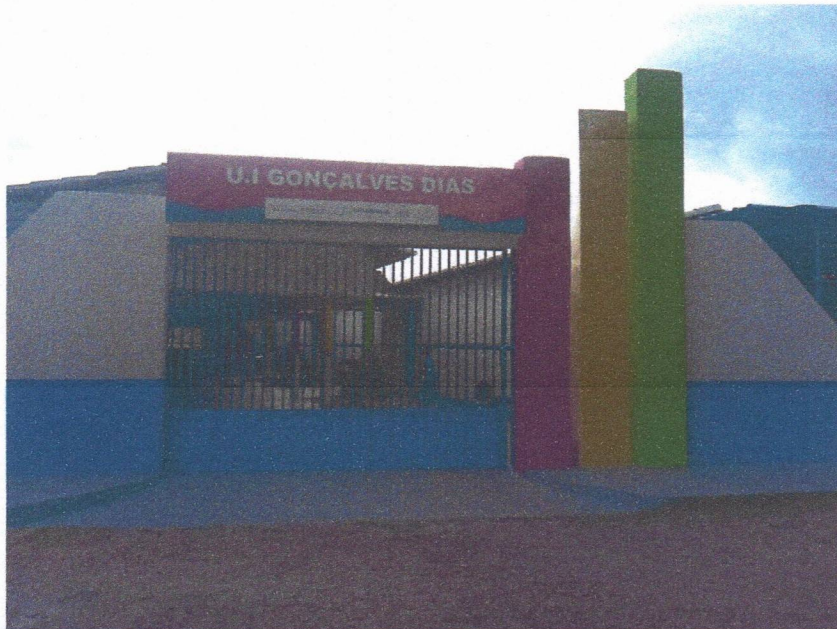
Imagem 22 – Pintura da fachada da escola.
