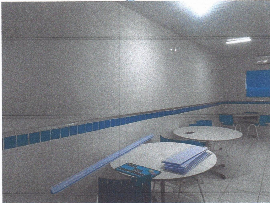
Imagem 3 – Pintura Interna da escola.
