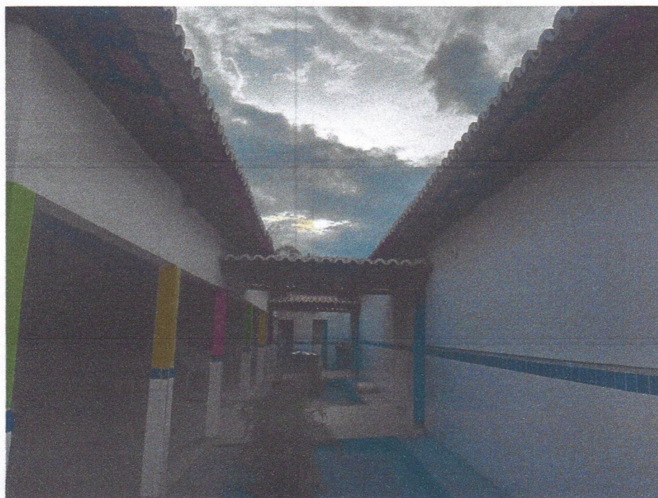
Imagem 1 – Retelhameto com telha cerâmica.
