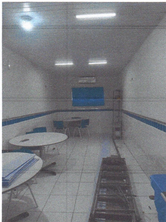
Imagem 9 – Pintura interna da escola.
