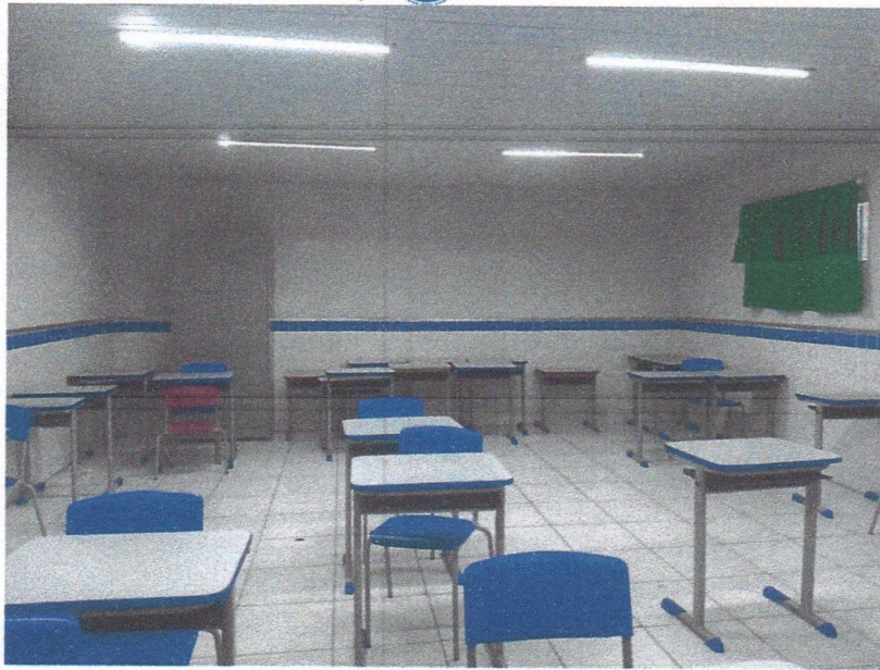
Imagem 7 – Pintura interna da escola.
