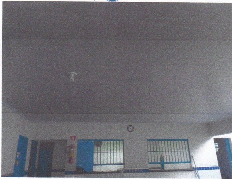
Imagem 11 – Instalação de Forro de PVC.
