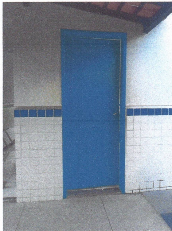
Imagem 14 – Pintura interna e pintura das esquadrias de madeira.
