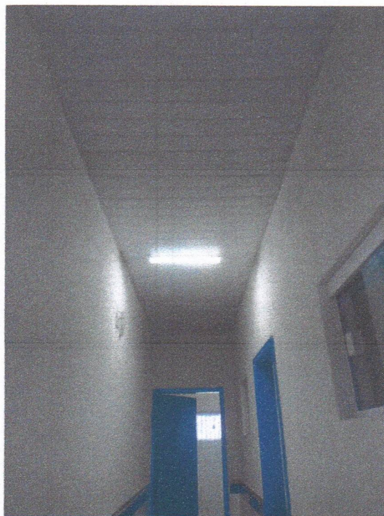
Imagem 10 – Pintura interna da escola.
