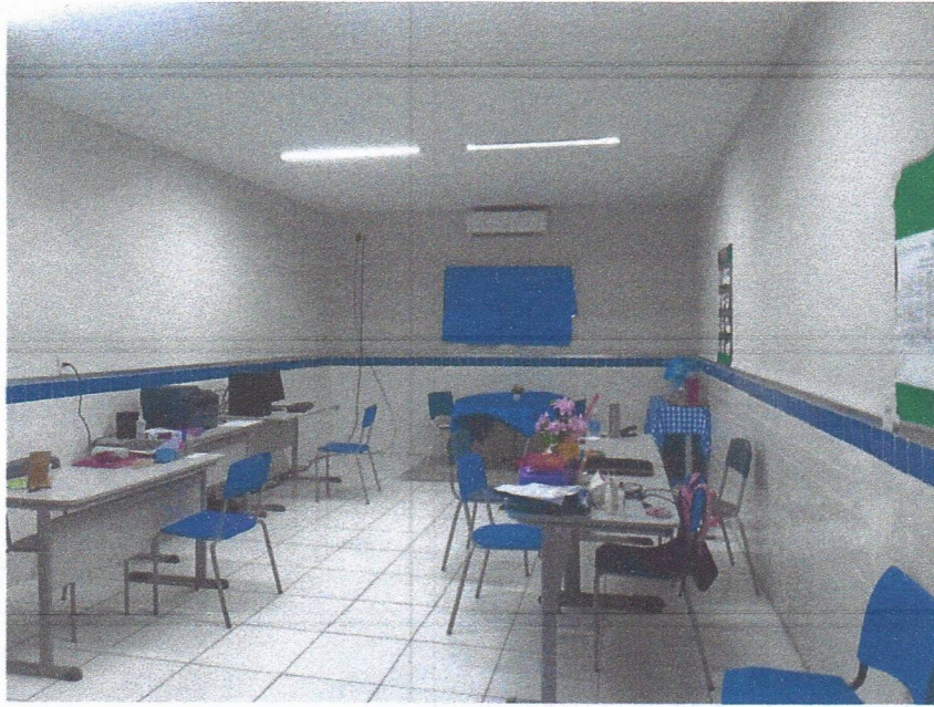
Imagem 5 – Pintura interna da escola.
