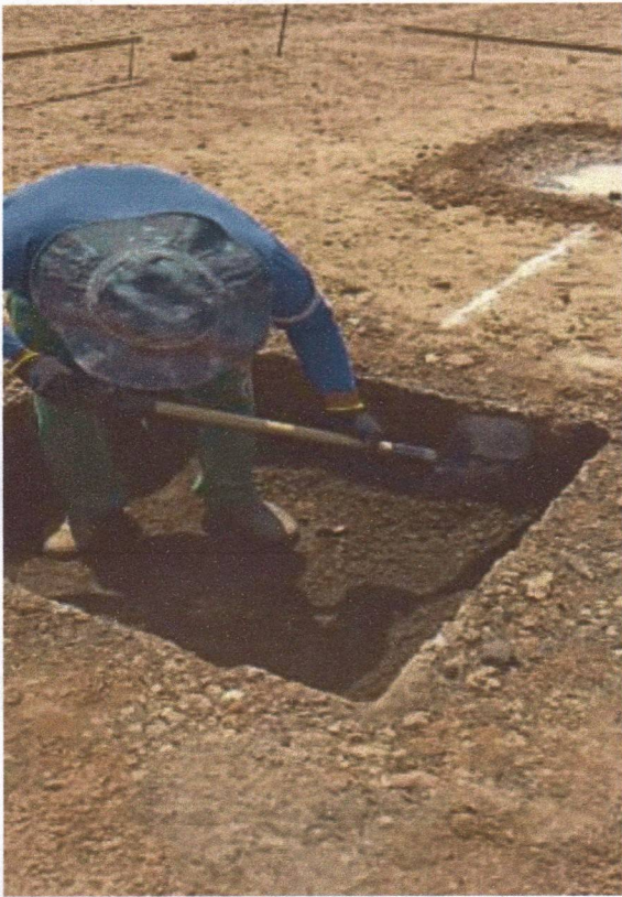
Figura 13 – CONSTRUÇÃO DE UMA UNIDADE ESCOLAR - Medição 01 – Escavação de Sapata.
