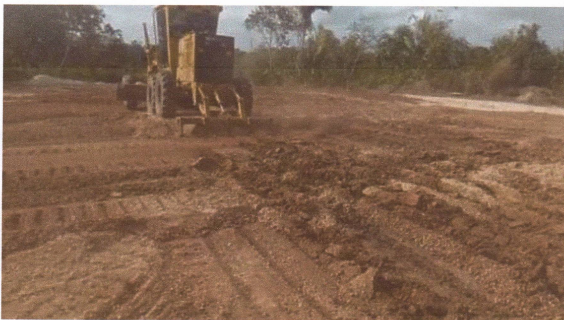
Figura 18 – CONSTRUÇÃO DE UMA UNIDADE ESCOLAR - Medição 01 – Quebra de camadas compactadas e preparação para fundação.
