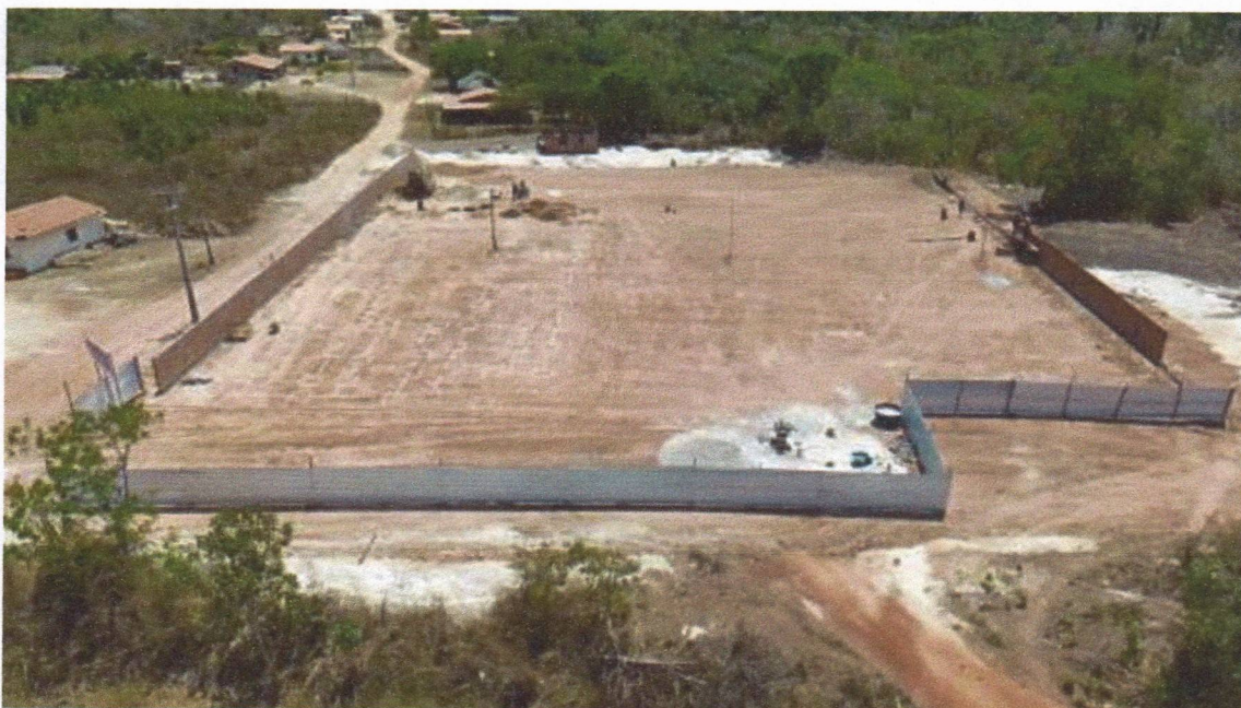
Figura 28 – CONSTRUÇÃO DE UMA UNIDADE ESCOLAR - Medição 01 – Vista geral do terreno com marcação das fundações e avanço da alvenaria de fechamento lateral.
