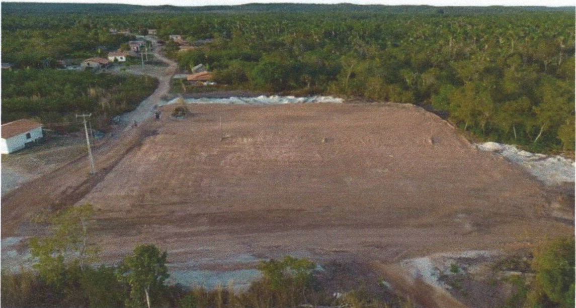
Figura 6 – CONSTRUÇÃO DE UMA UNIDADE ESCOLAR - Medição 01 – Vista superior do terreno após terraplenagem.
