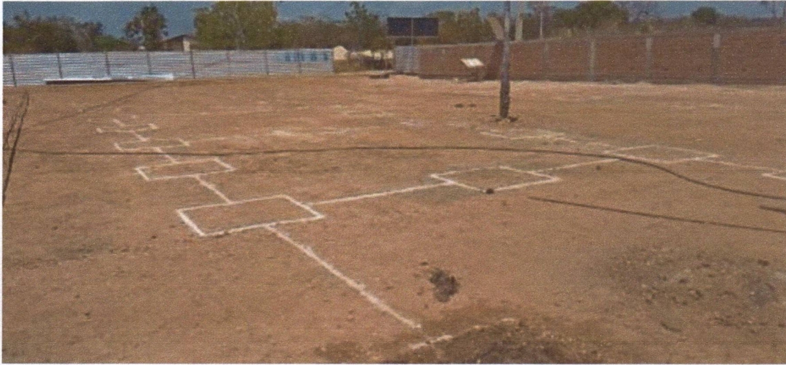
Figura 11 – CONSTRUÇÃO DE UMA UNIDADE ESCOLAR - Medição 01 – Marcação do Terreno.
