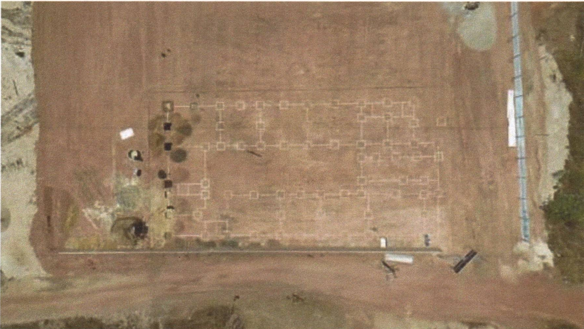
Figura 24 – CONSTRUÇÃO DE UMA UNIDADE ESCOLAR - Medição 01 – Visão aérea das marcações e escavações de sapatas.
