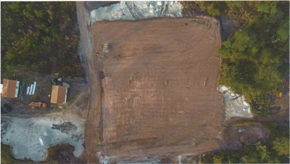
Figura 5 – CONSTRUÇÃO DE UMA UNIDADE ESCOLAR - Medição 01 – Vista superior do terreno após terraplenagem.
