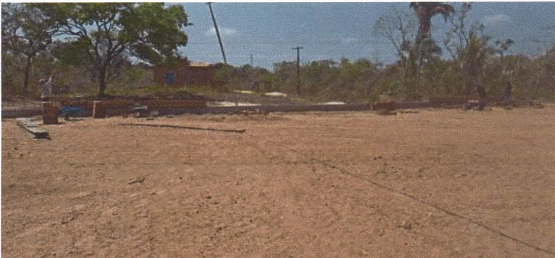
Figura 10 – CONSTRUÇÃO DE UMA UNIDADE ESCOLAR - Medição 01 – Elevação de Alvenaria.
