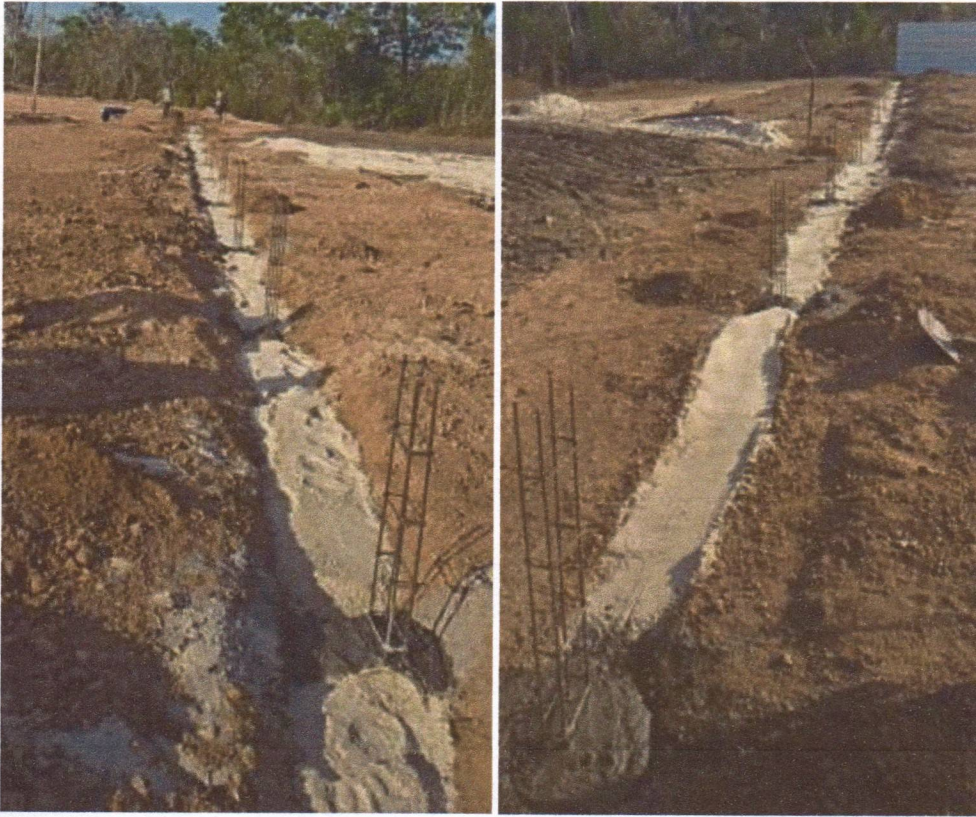
Figura 19 – CONSTRUÇÃO DE UMA UNIDADE ESCOLAR - Medição 01 – Execução de valas e armação das sapatas corridas — preparação das fundações.
