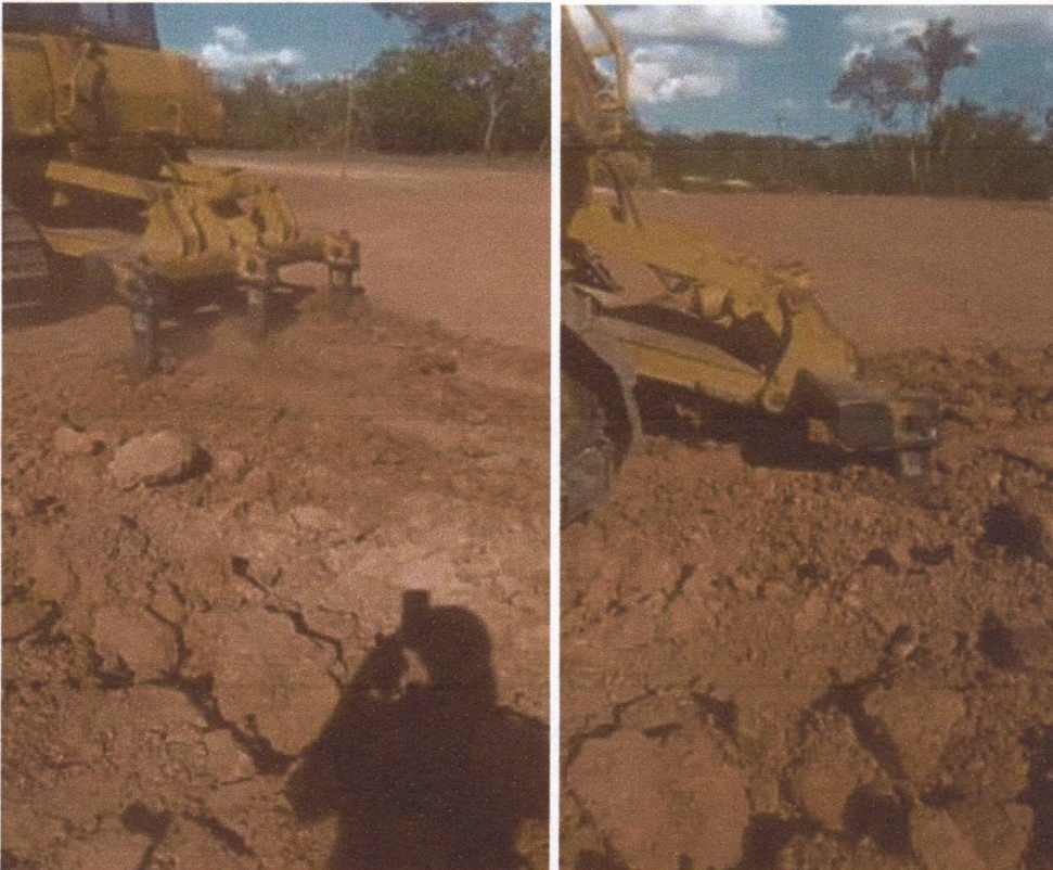
Figura 16 – CONSTRUÇÃO DE UMA UNIDADE ESCOLAR - Medição 01 – Quebra de camadas compactadas e preparação para fundação.
