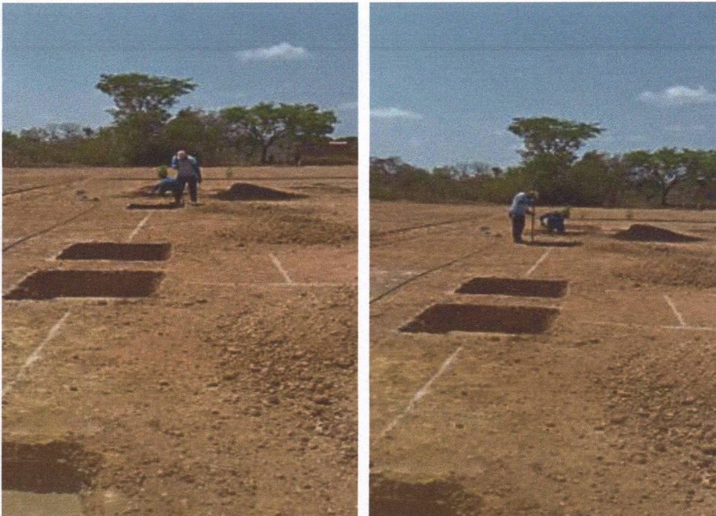
Figura 14 – CONSTRUÇÃO DE UMA UNIDADE ESCOLAR - Medição 01 – Escavação de Sapata.
