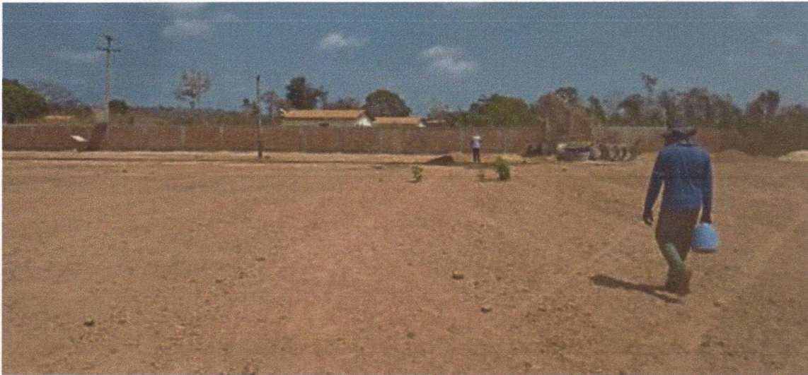
Figura 7 – CONSTRUÇÃO DE UMA UNIDADE ESCOLAR - Medição 01 – Vista Geral do Canteiro.
