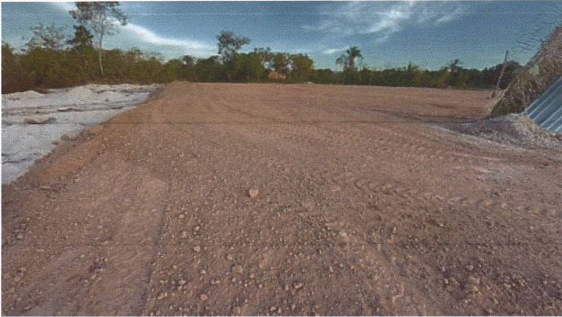
Figura 3 – CONSTRUÇÃO DE UMA UNIDADE ESCOLAR - Medição 01 – Área de terraplenagem concluída.
