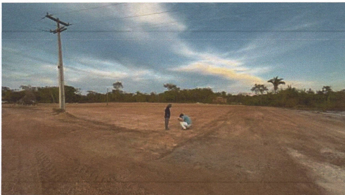
Figura 1 – CONSTRUÇÃO DE UMA UNIDADE ESCOLAR - Medição 01 – Finalização da etapa de terraplenagem, demonstrando uniformidade da compactação do solo.
