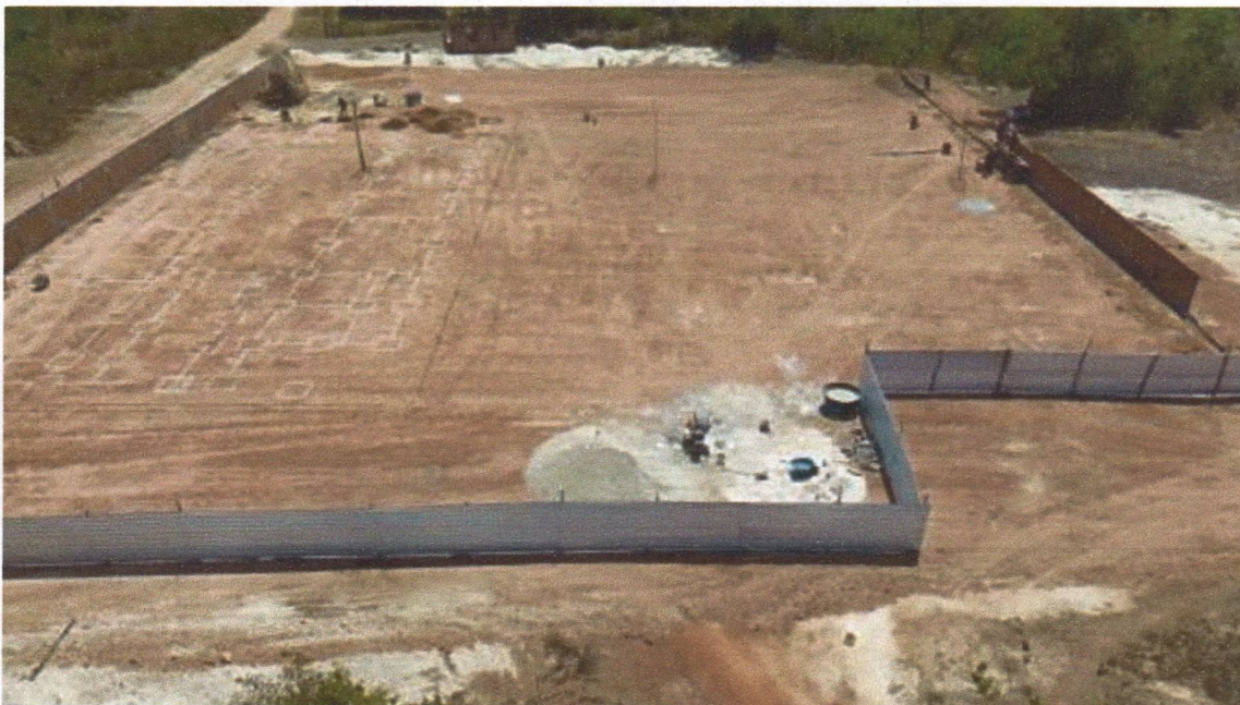
Figura 25 – CONSTRUÇÃO DE UMA UNIDADE ESCOLAR - Medição 01 – Visão aérea do canteiro de obras com montagem de tapume metálico.
