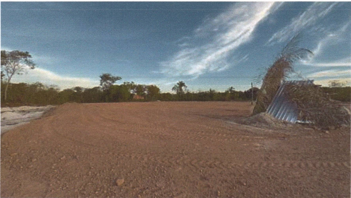
Figura 4 – CONSTRUÇÃO DE UMA UNIDADE ESCOLAR - Medição 01 – Área de terraplenagem concluída.
