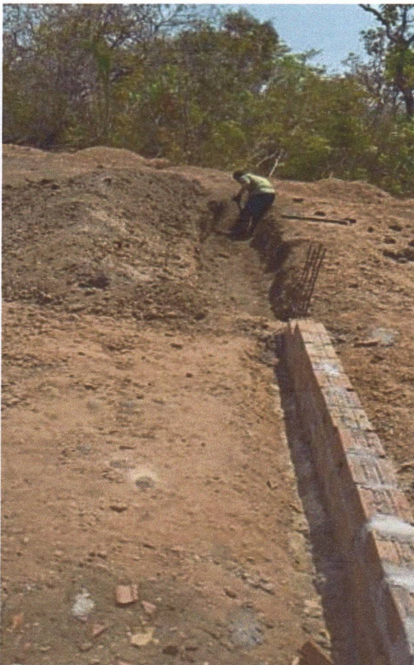
Figura 8 – CONSTRUÇÃO DE UMA UNIDADE ESCOLAR - Medição 01 – Escavação de baldrame para execução da fundação da alvenaria de vedação.
