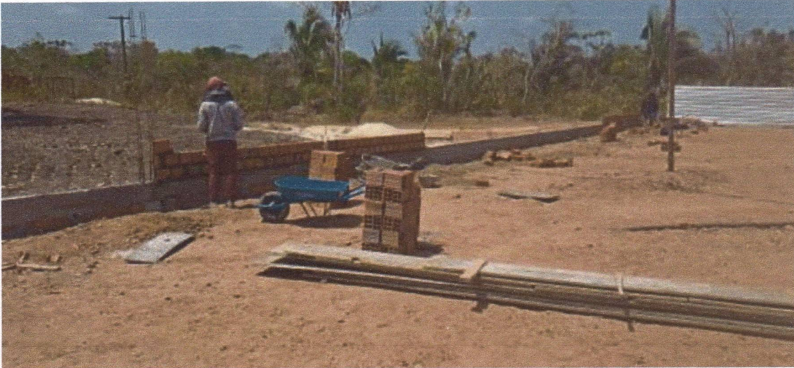
Figura 9 – CONSTRUÇÃO DE UMA UNIDADE ESCOLAR - Medição 01 – Elevação de Alvenaria.
