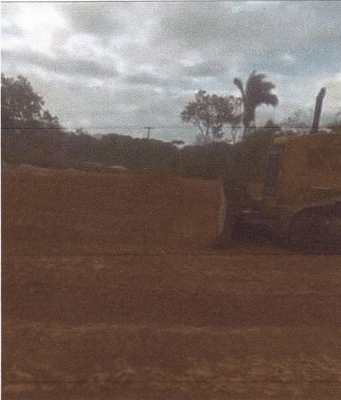
Figura 15 – CONSTRUÇÃO DE UMA UNIDADE ESCOLAR - Medição 01 – Terraplenagem com trator de esteira.
