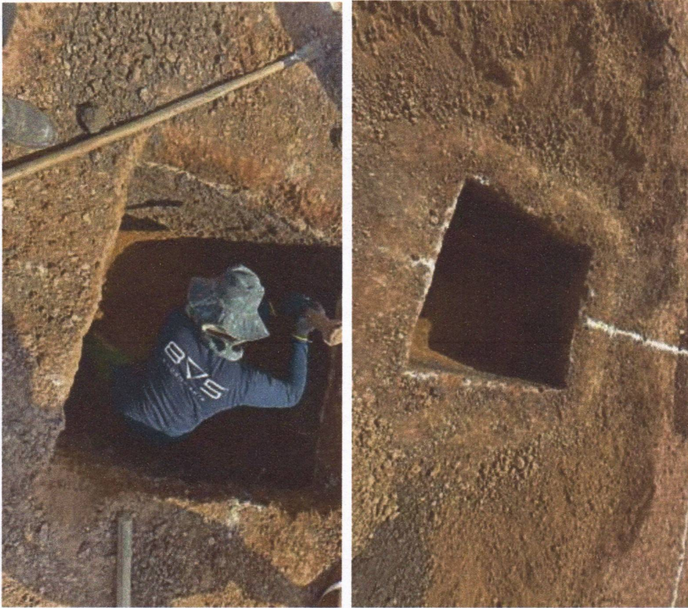
Figura 23 – CONSTRUÇÃO DE UMA UNIDADE ESCOLAR - Medição 01 – Escavação de Sapata.
