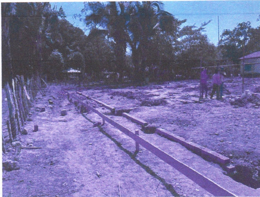
Imagem 3 – Execução do nivelamento do terreno com alvenaria e escavação das fundações.
