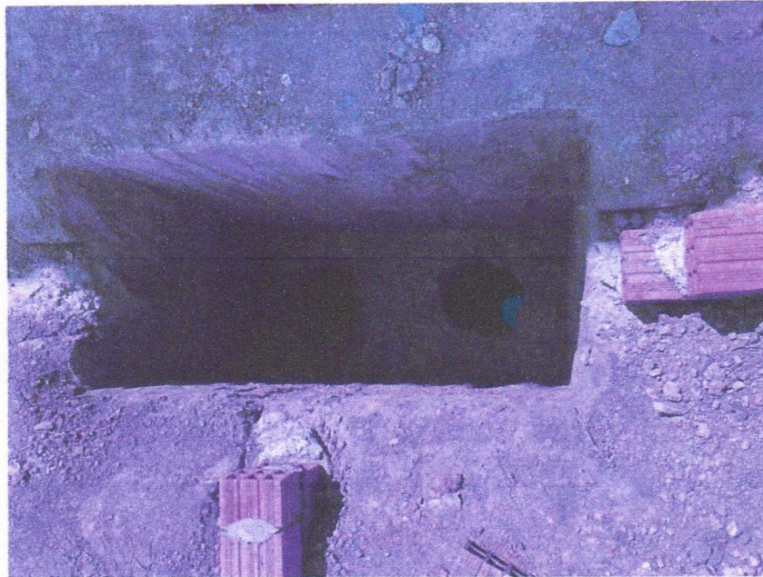
Imagem 5 – Execução das escavações das estacas.
