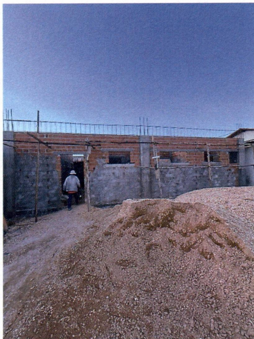
Imagem 1 – Execução de alvenarias, ferragens de vigas, pilares, chapisco;
