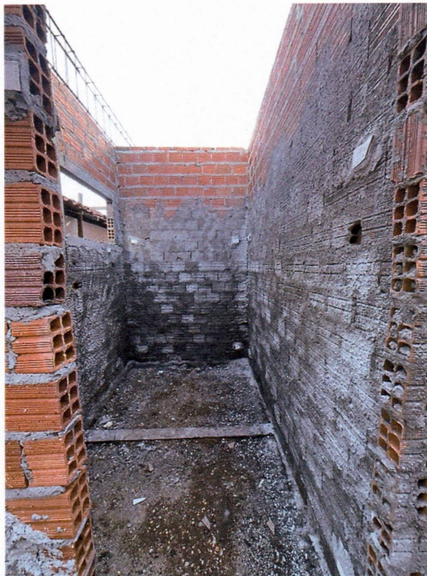
Imagem 4 – Execução de vergas e contravergas, aterro, chapisco e alvenarias;
