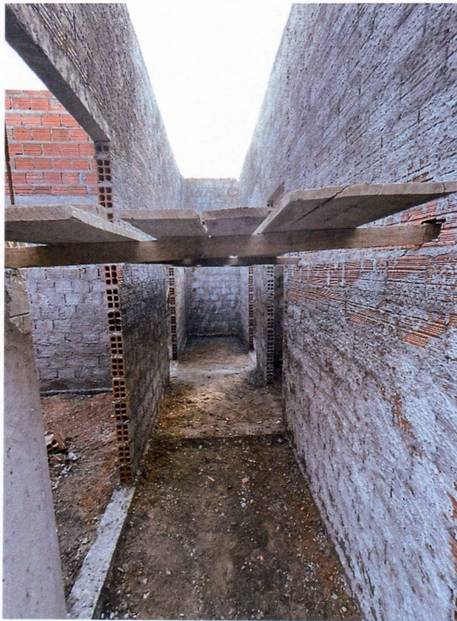
Imagem 11 – Execução de chapisco, alvenaria, aterro e pilares no centro cirúrgico;
