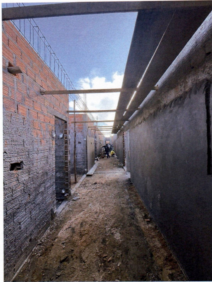
Imagem 7 – Execução de rebocos;
