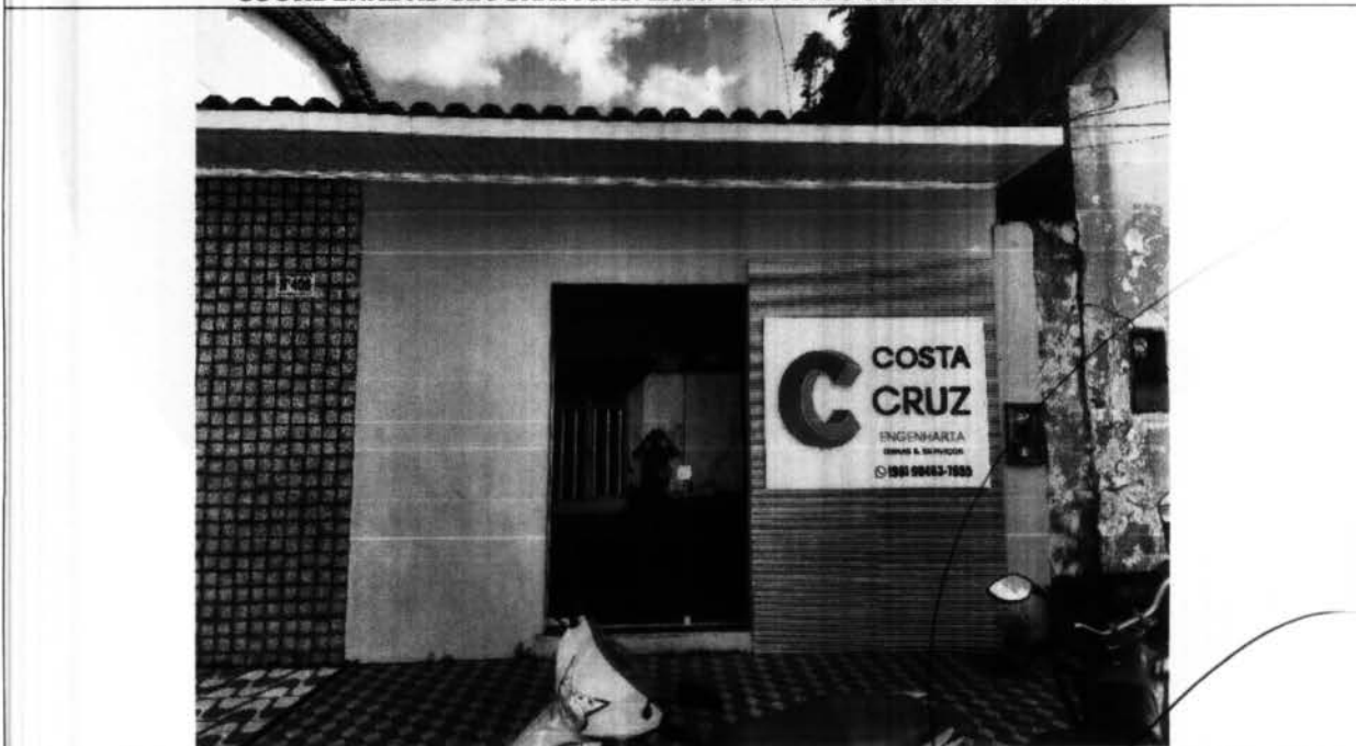
FOTO 06. FACHADA COORDENADAS GEOGRÁFICAS: LAT.: -3.395980 e LONG.: -44.356847
