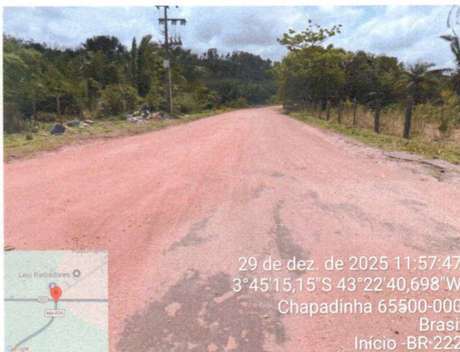
FOTO 1: INÍCIO DO TRECHO – KM 0.00
